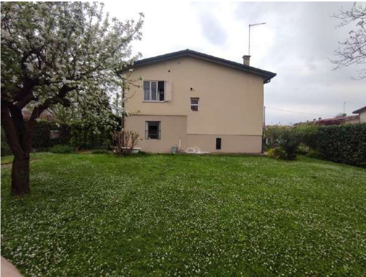
Vista del retro dal lato ovest
