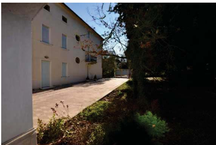
foto n. 3 – prospetto ovest dal porticato
