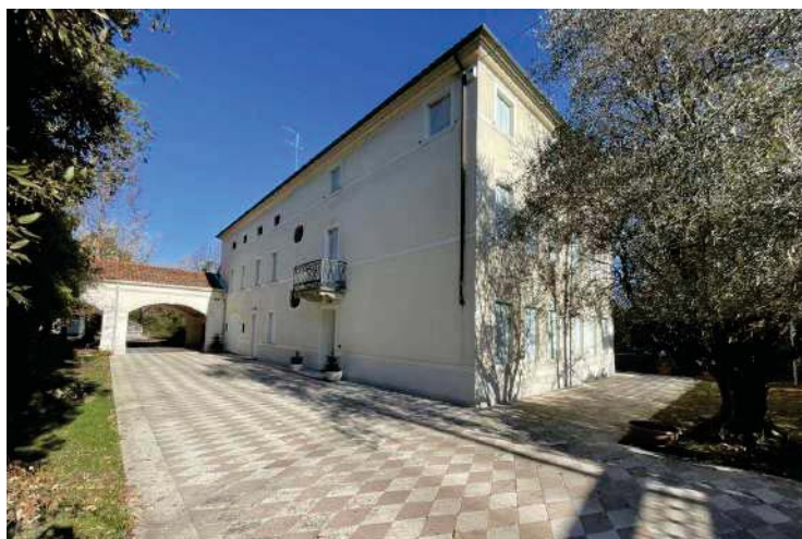
foto n. 2 – prospetto principale ovest della villa
