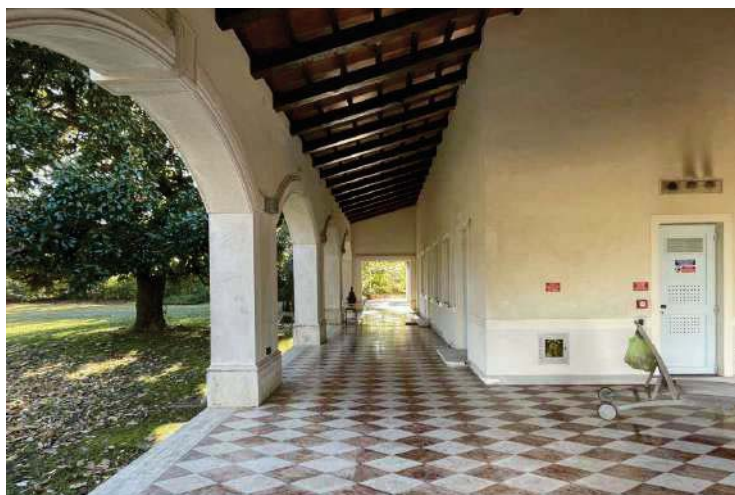
foto n. 7 – porticato lungo il prospetto est
