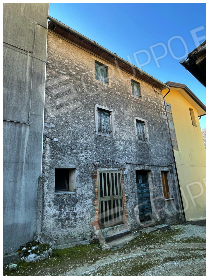
Prospetto Nord dell'edificio (abitazione a schiera)
