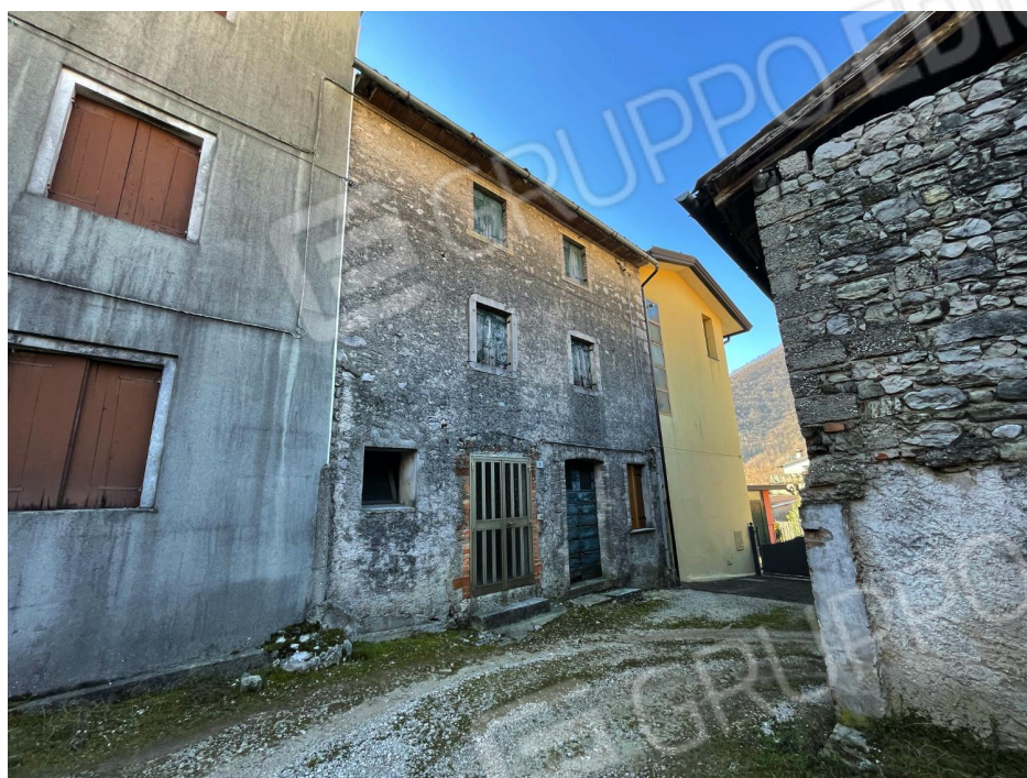
Prospetto Nord dell'edificio (abitazione a schiera)
