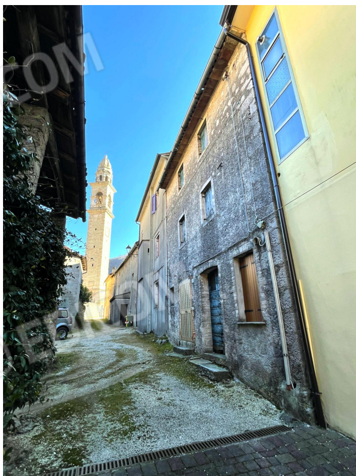
Prospetto Nord dell'edificio (abitazione a schiera)
