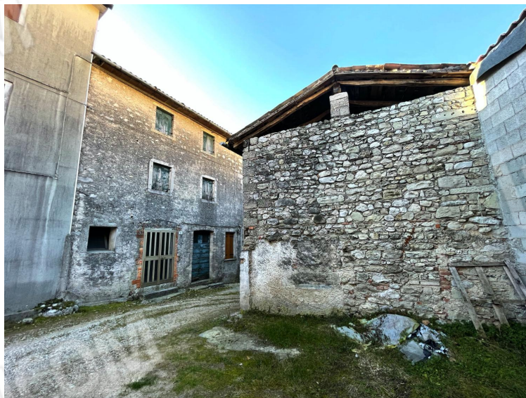
Prospetto Est dell'edificio (corpo di fabbrica di servizio ad uso autorimessa con soffitta)
