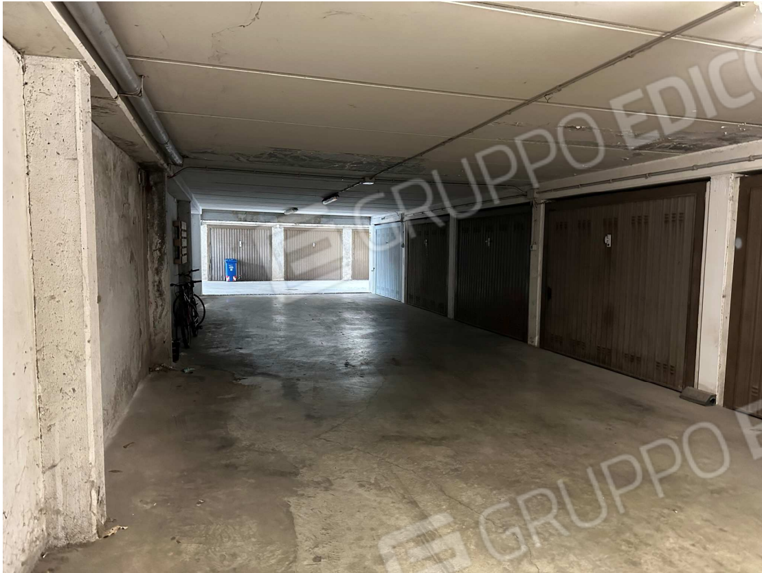
Piano interrato - area di manovra
