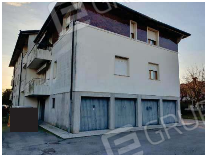
FOTO 2: vista lato ovest
