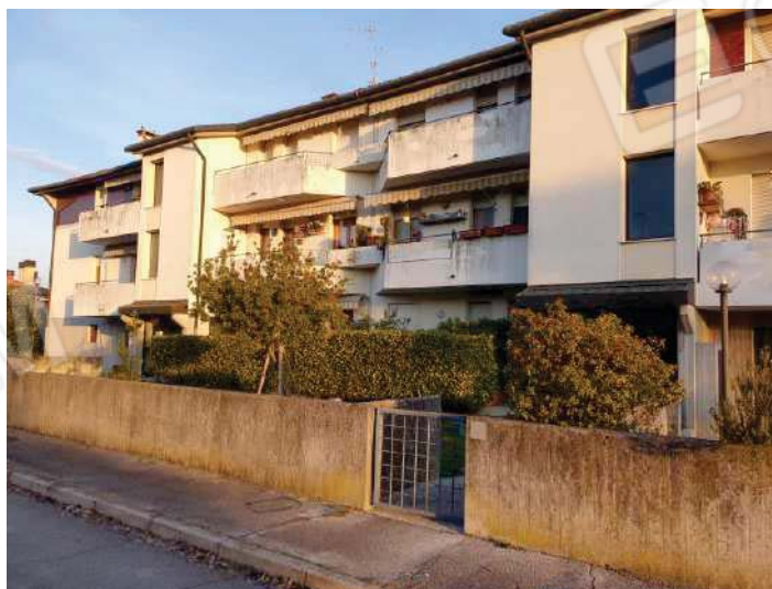
FOTO 1: vista lato sud
