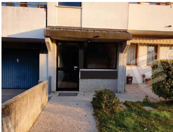
FOTO 3: vista vano scala esterno – lato sud
