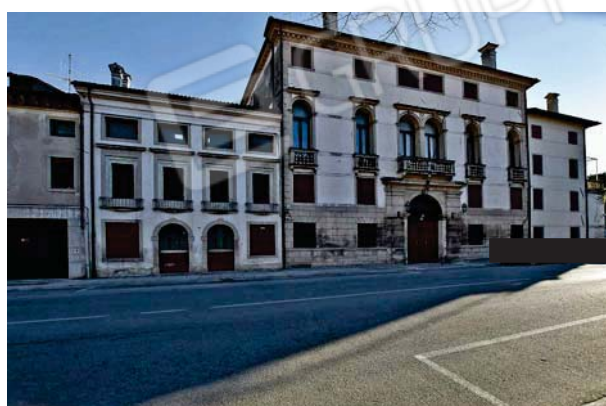
6. Prospetto principale (2 di 3).
