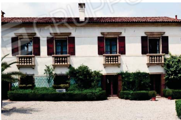
4. Prospetto interno barchessa nord.
