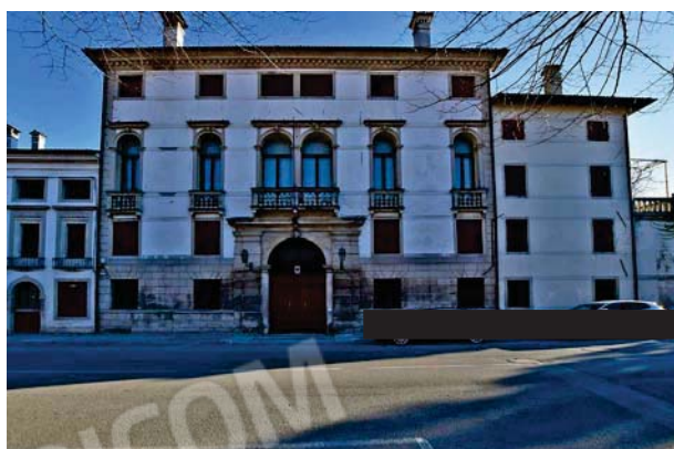
5. Prospetto principale (1 di 3).
