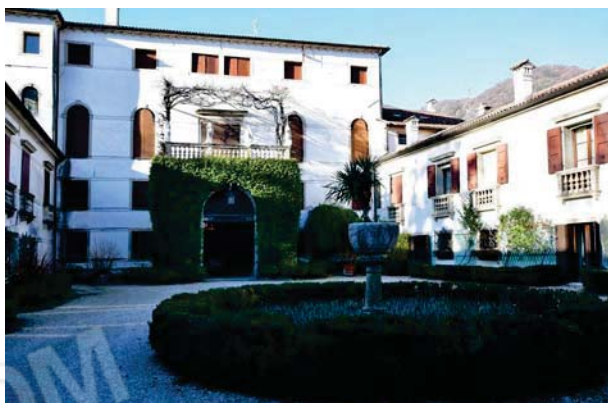
3. Prospetto interno palazzo e barchessa nord.
