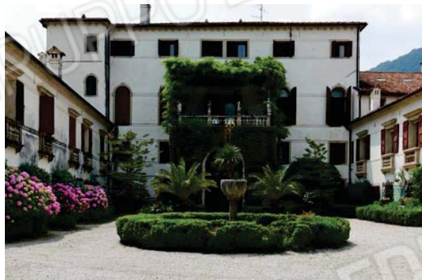
2. Prospetto interno palazzo.
