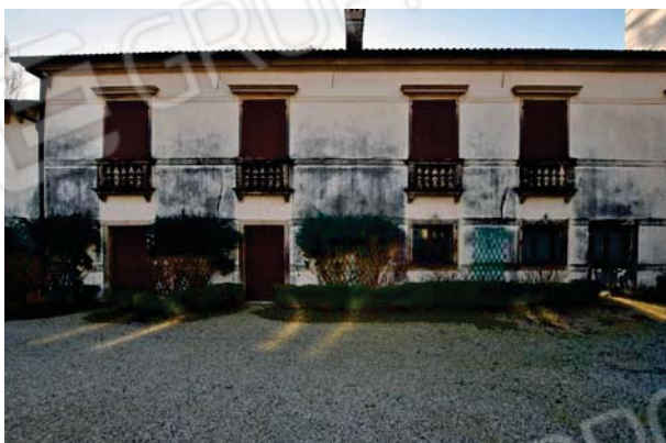
10. Prospetto interno barchessa sud (2 di 2).
