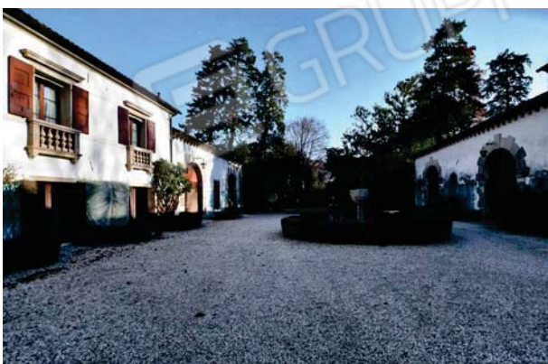
6. Prospettiva interna barchessa nord (1 di 2).
