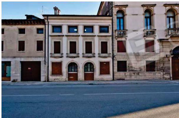
7. Prospetto principale (3 di 3).
