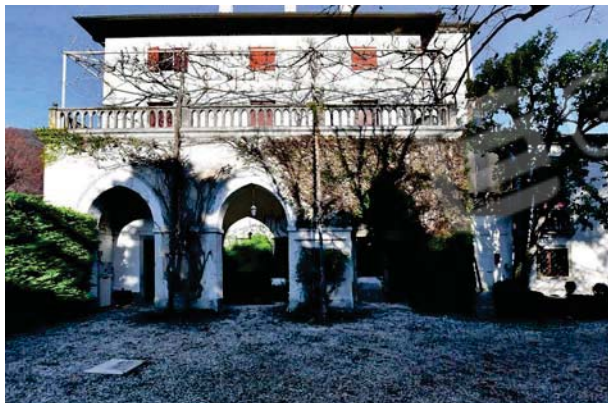
1. Prospetto interno sud.
