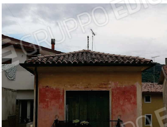
Foto 30. Vista copertura Ovest
