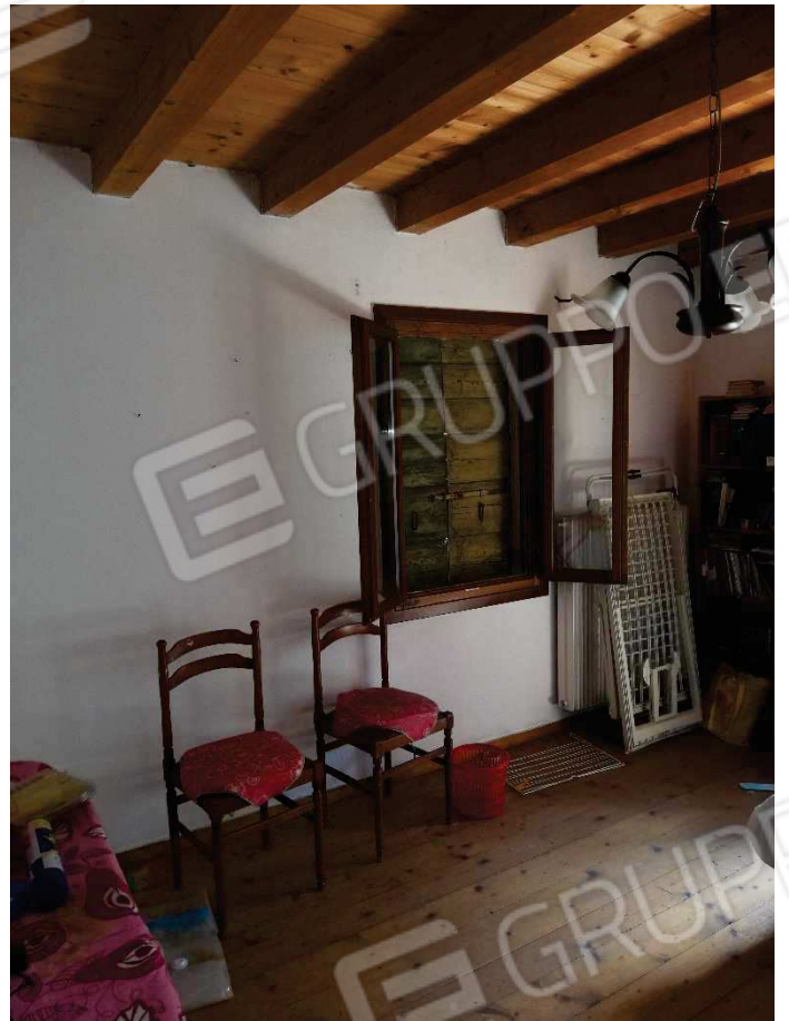
Foto 18. Vista Camera al piano primo
