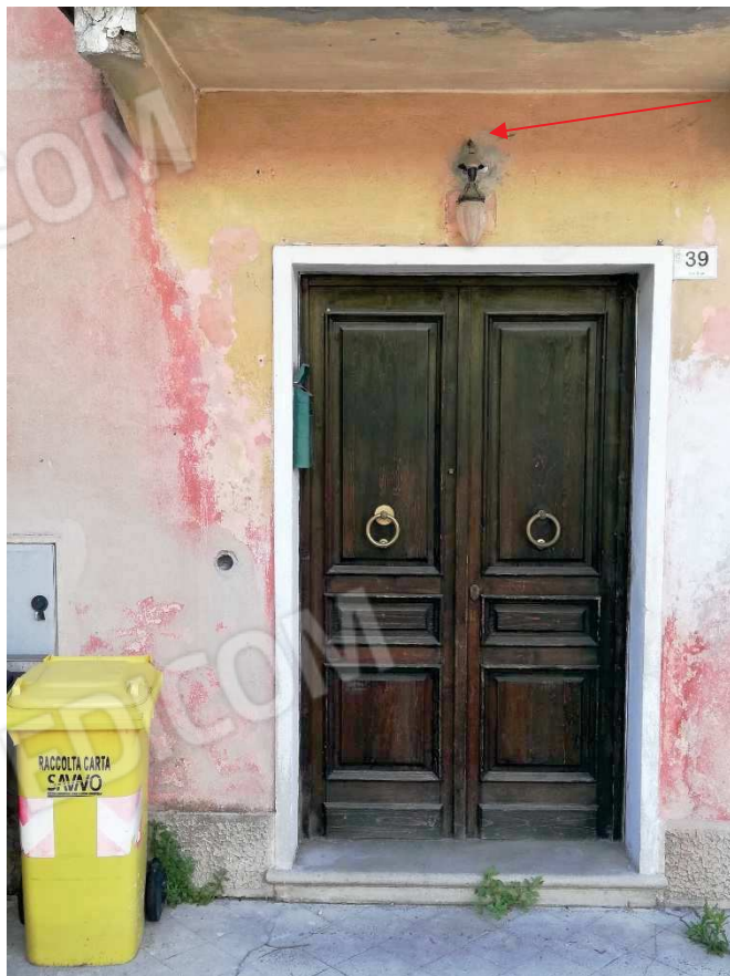
Foto 5. Vista Ovest - Ingresso
