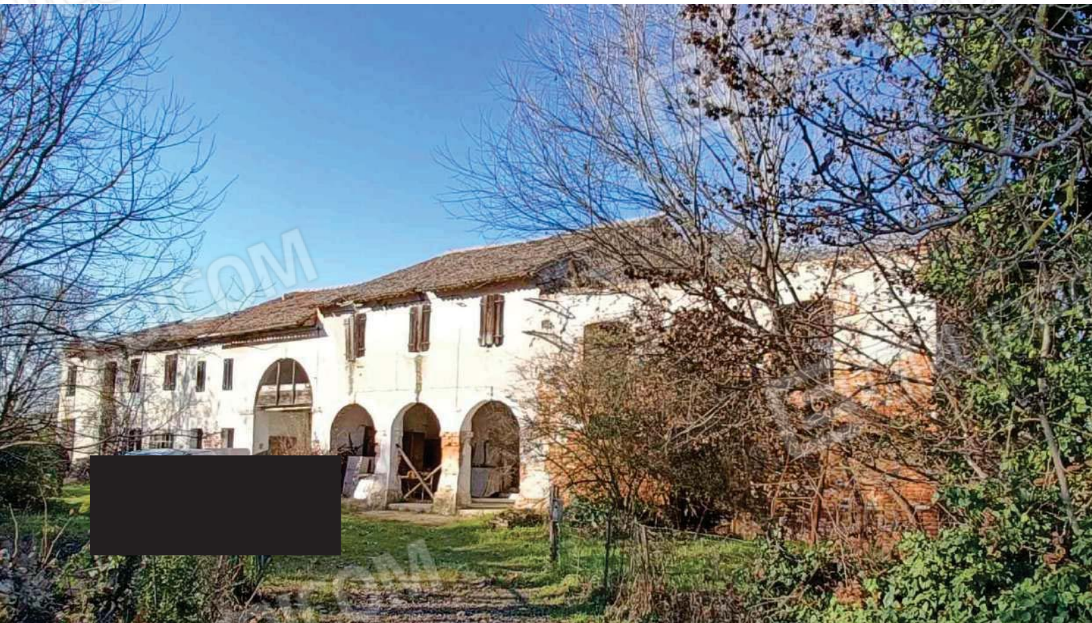
Foto 02 – prospetto sud fabbricato principale
