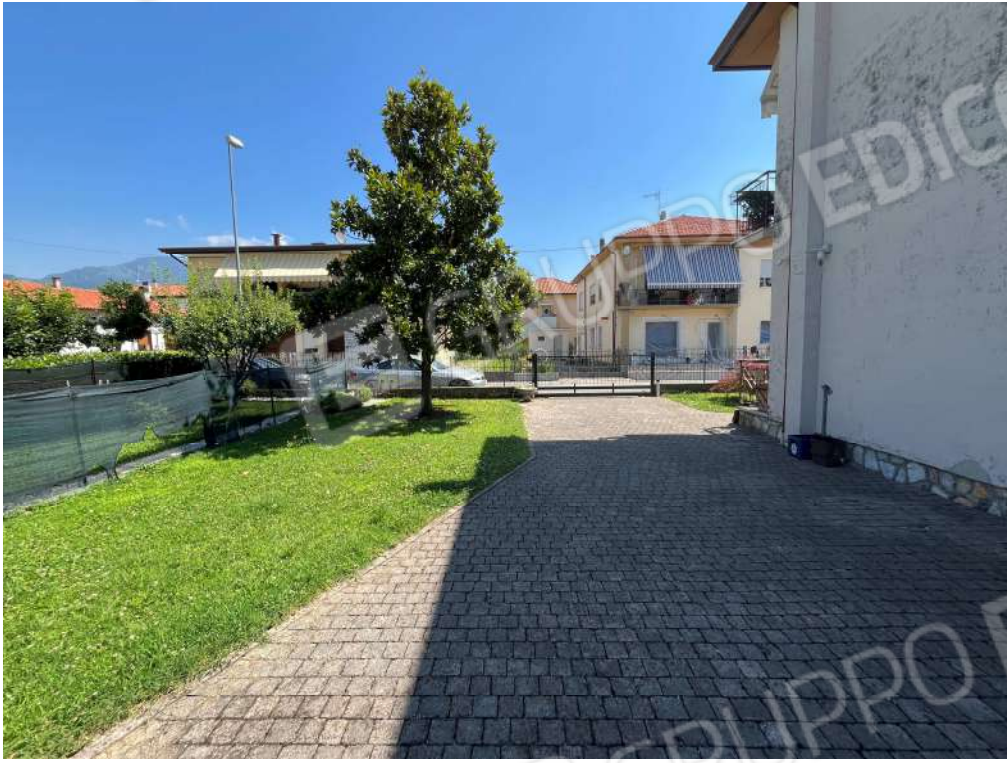
N.5 – Vista area scoperta
