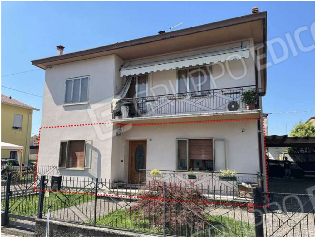
N.3 – Vista nord-est
