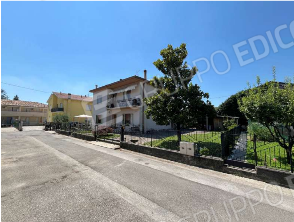
N.1 – Ingresso da via Arnaldo Fusinato
