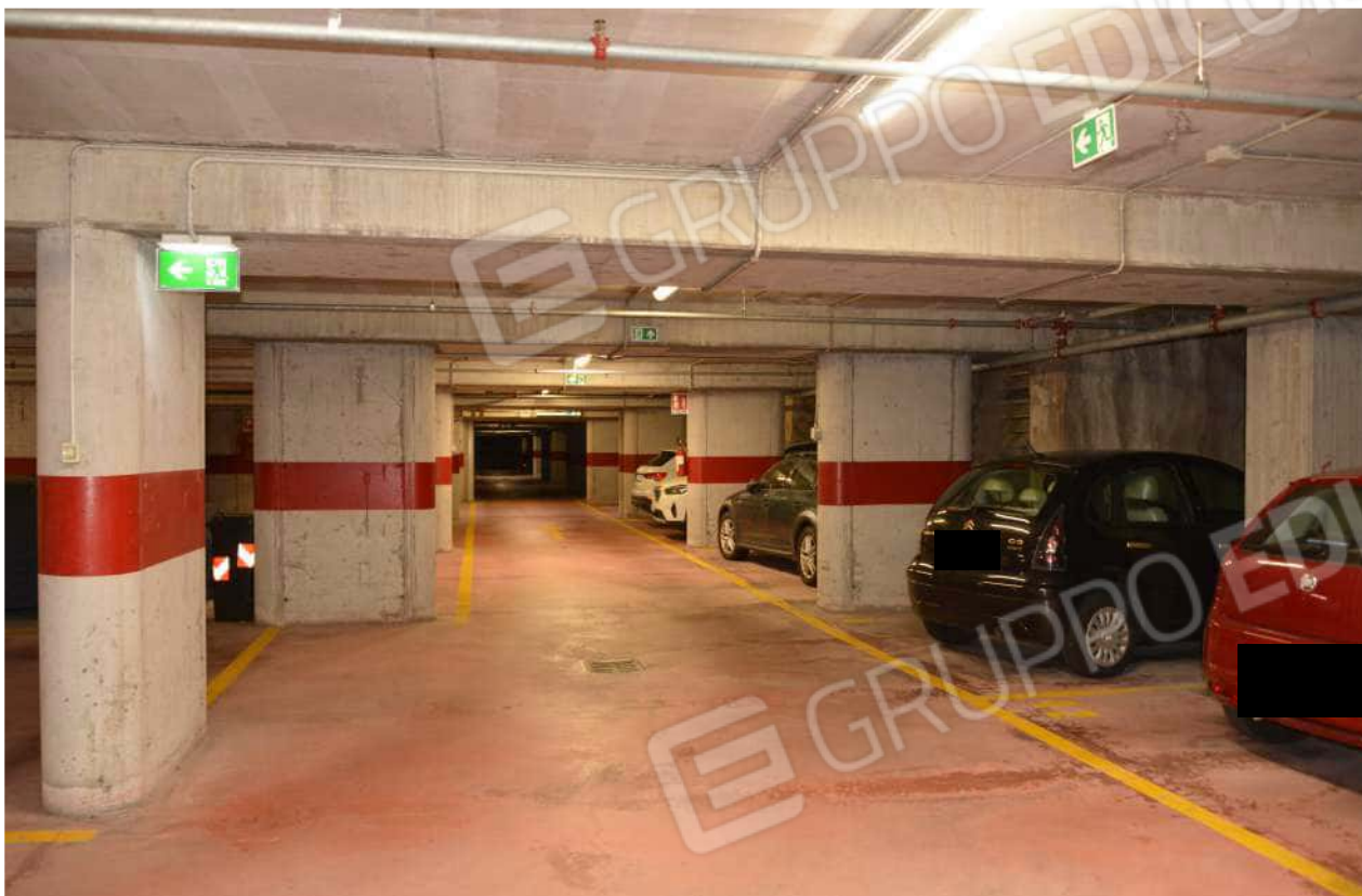
Foto n. 37 corsia di manovra garage interrato terzo piano sottostrada
