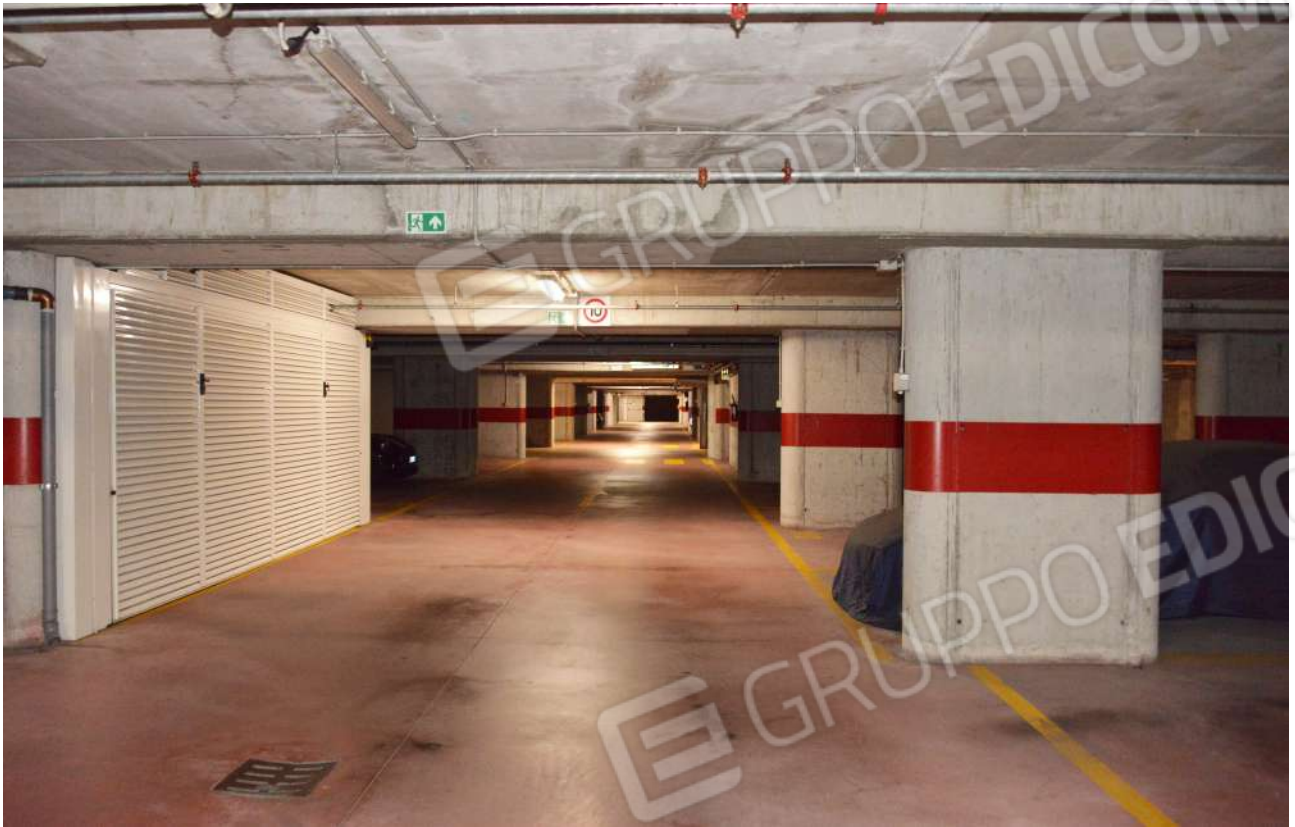
Foto n. 39 corsia di manovra garage interrato terzo piano sottostrada
