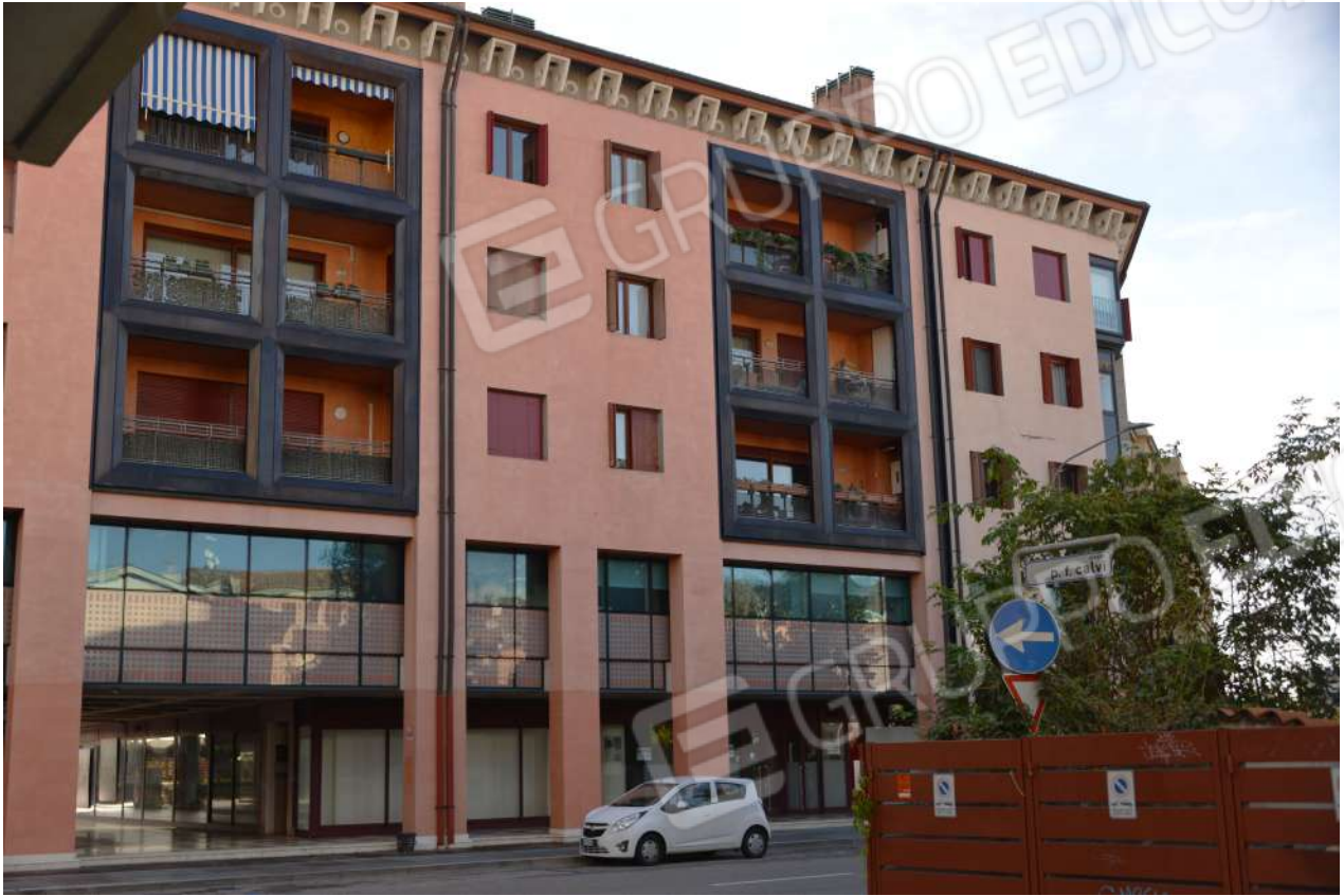
Foto n. 3 Via Cristoforo Colombo – particolare fronte Nord “Shopping Center”
