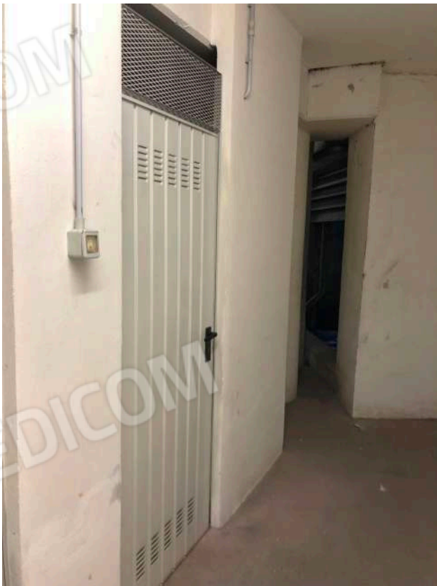
Foto n. 42 corridoio e ingr.cantina sub 403
