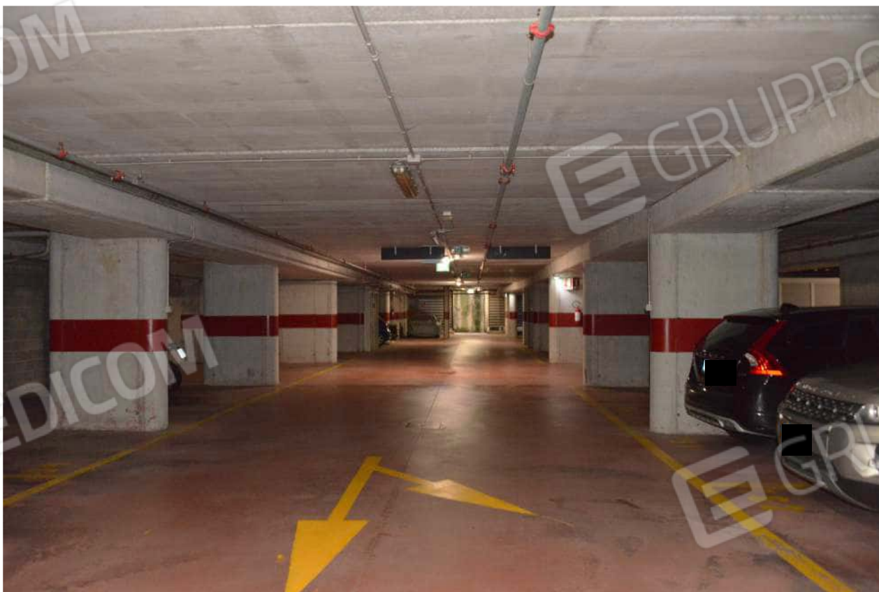
Foto n. 38 corsia di manovra garage interrato terzo piano sottostrada
