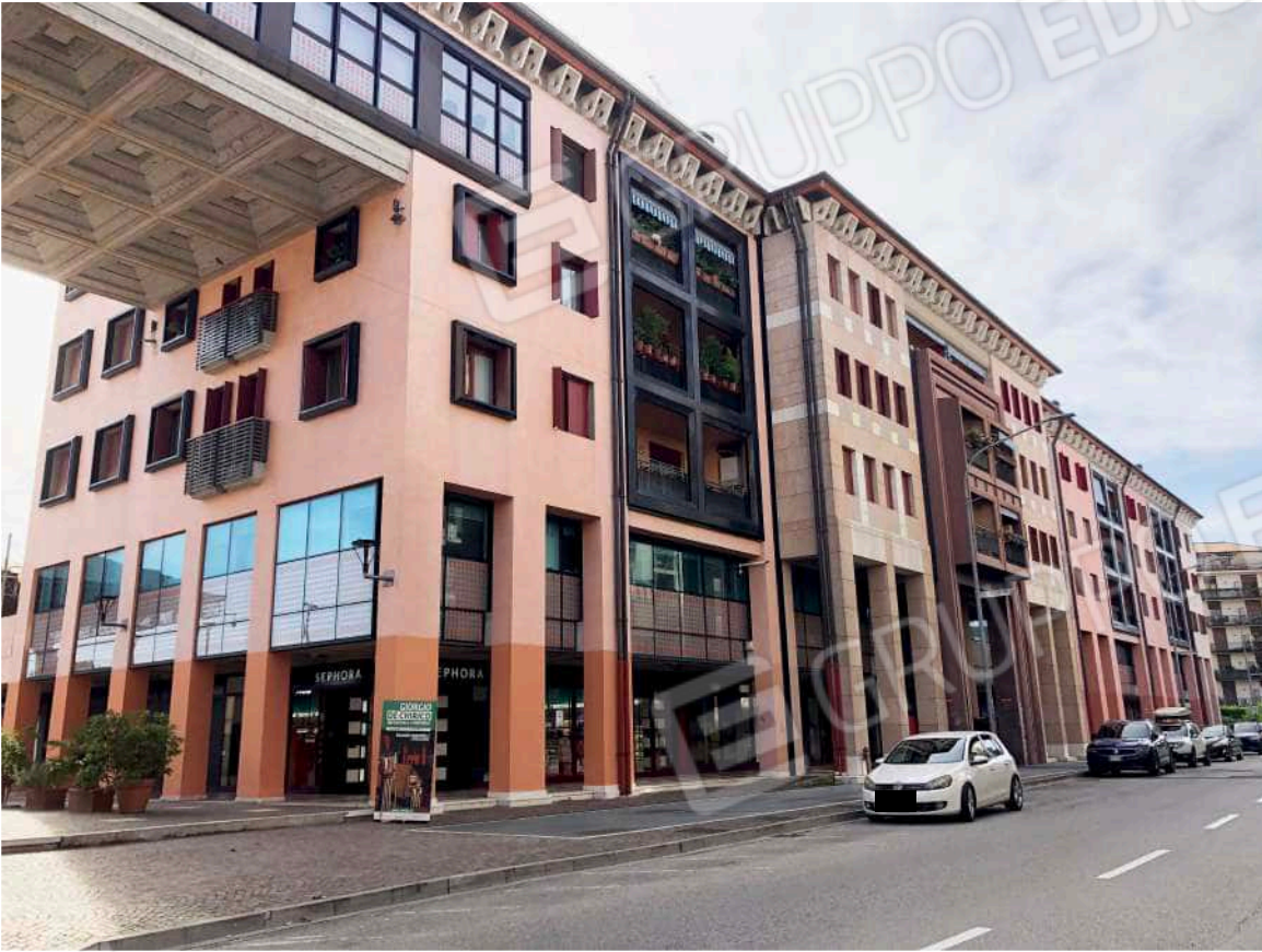
Foto n. 1 Via Cristoforo Colombo – “Shopping Center” n. 84
