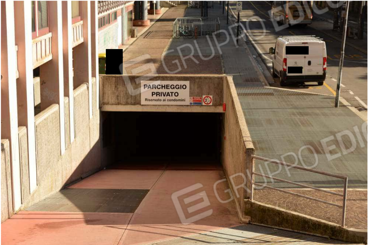
Foto n. 35 rampa di accesso piani sottostrada e garage
