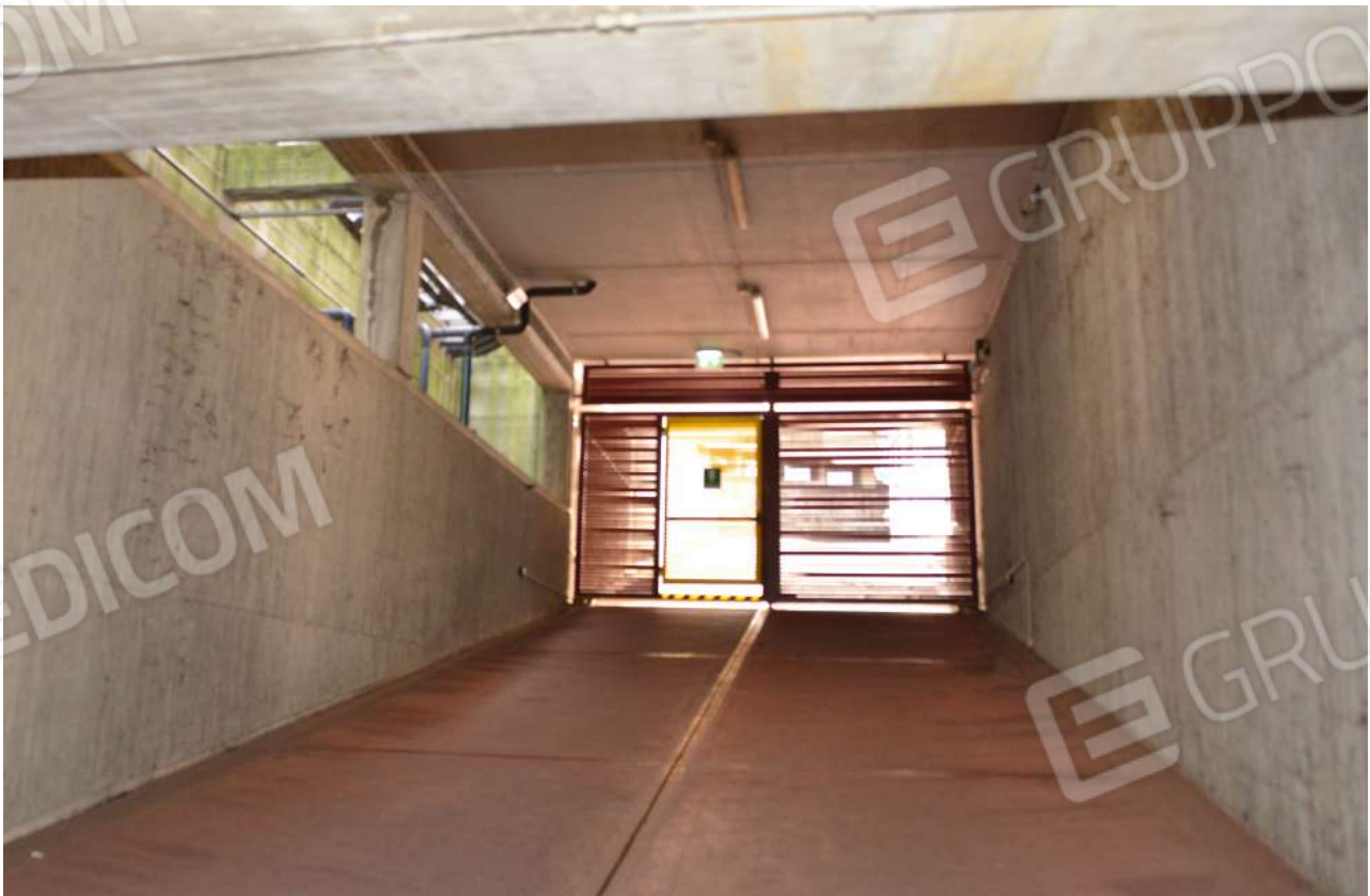
Foto n. 36 rampa di accesso piani sottostrada e garage
