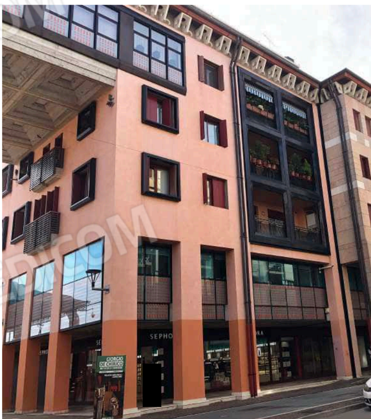
Foto n. 7 Shopping Center angolo Arco
