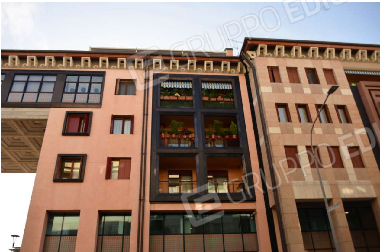
Foto n. 6 part. elementi costruttivi "Shopping Center" – fronte sub 115 3° piano
