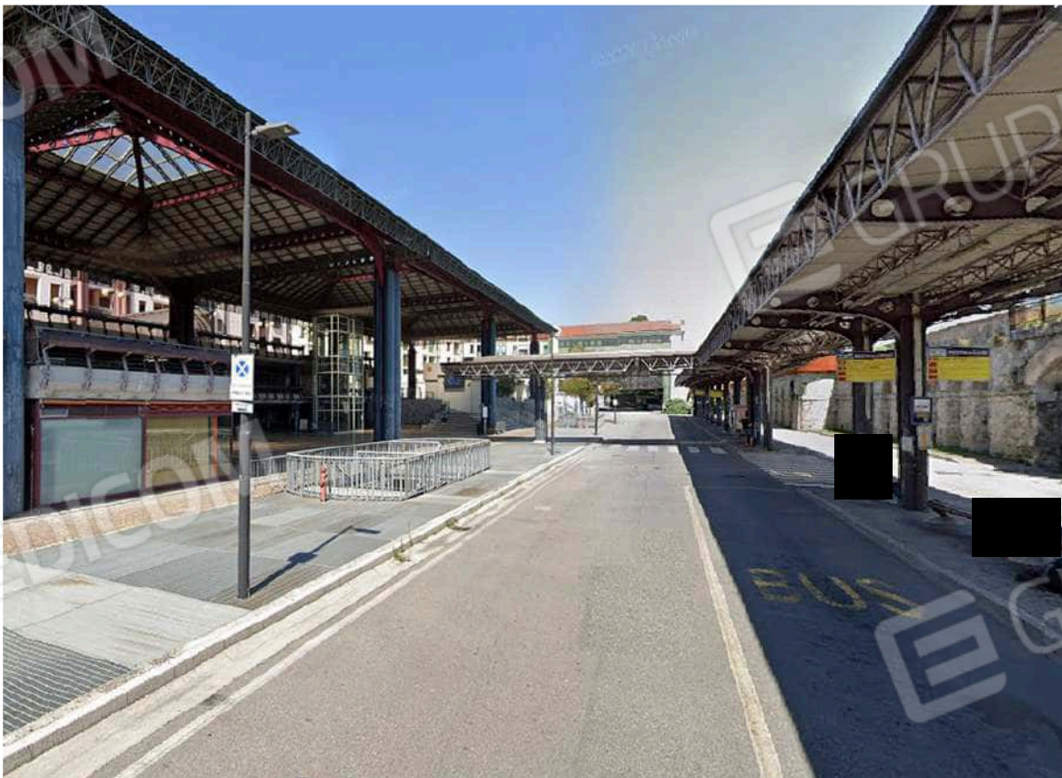
Foto n. 14 Shopping Center autostazione
