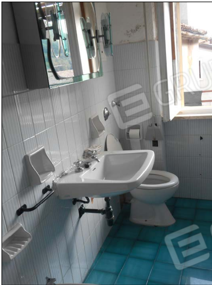
Stato di fatto del locale bagno
