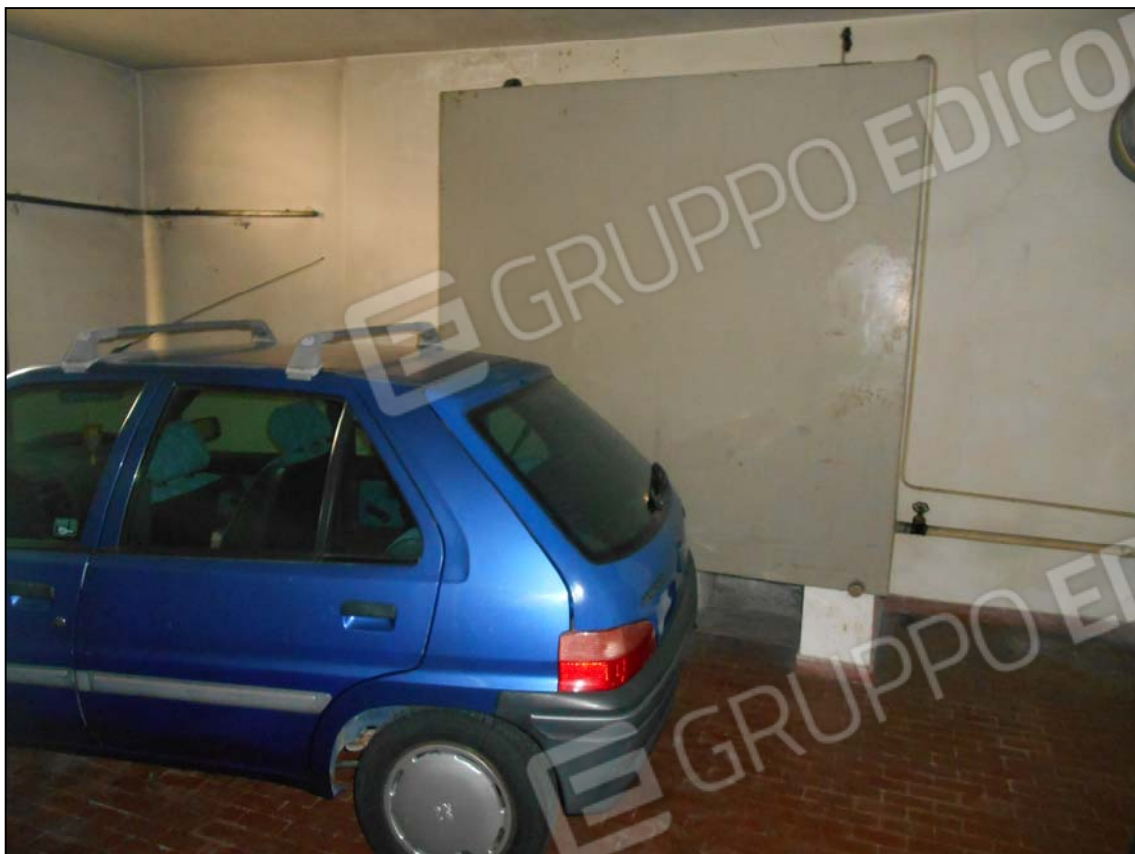
Locale lavanderia comune, sullo sfondo la cisterna del gasolio un tempo utilizzata dalla caldaia centralizzata e attualmente non funzionante
