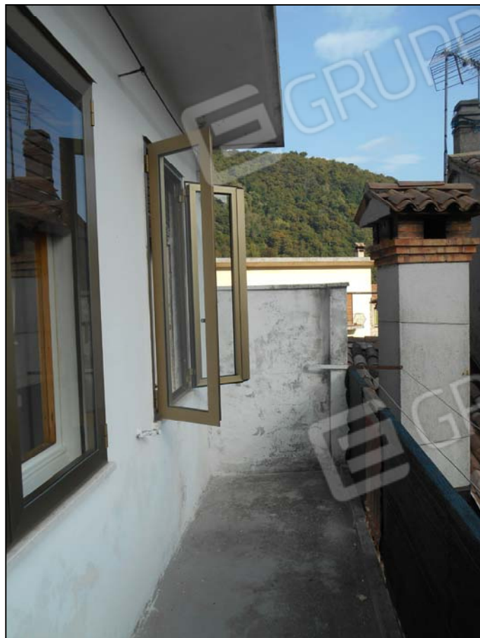
Terrazzo sud appartamento Ditta Esecutata con vista in direzione est
