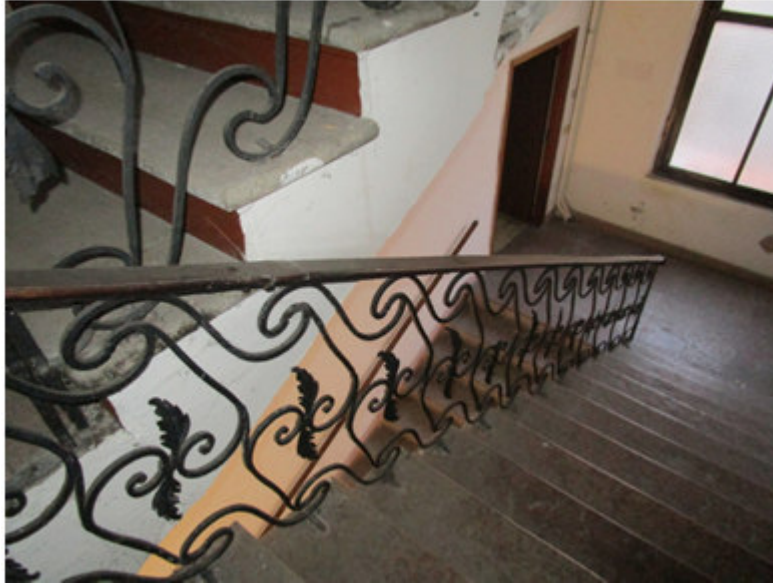
Vista vano scale da P.1 al P.2
