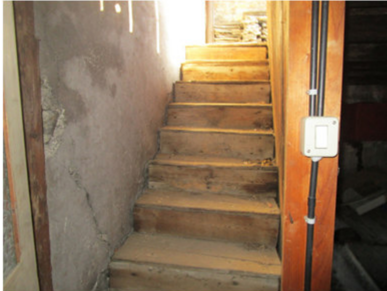
Vista vano scala al P.5
