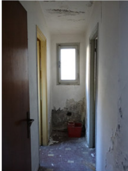
Vista ingresso w.c.
