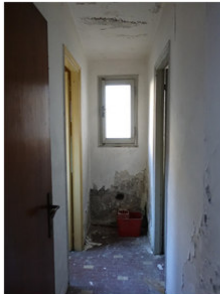
Vista corridoio w.c. al P.1
