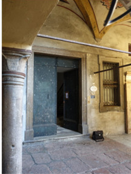
Vista portone d'ingresso
