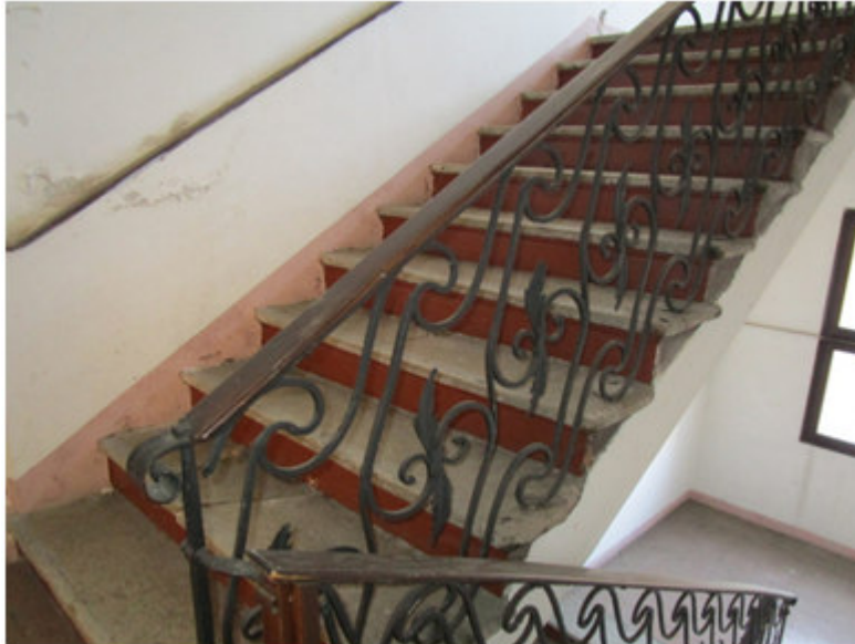
Vista su vano scala al P.3
