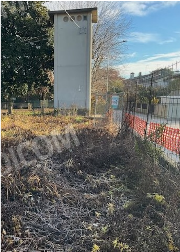
Foto 6 Confine sud e vista su cabina elettrica
