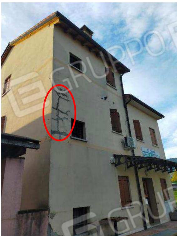
22. Criticità: intonaco esterno degradato
