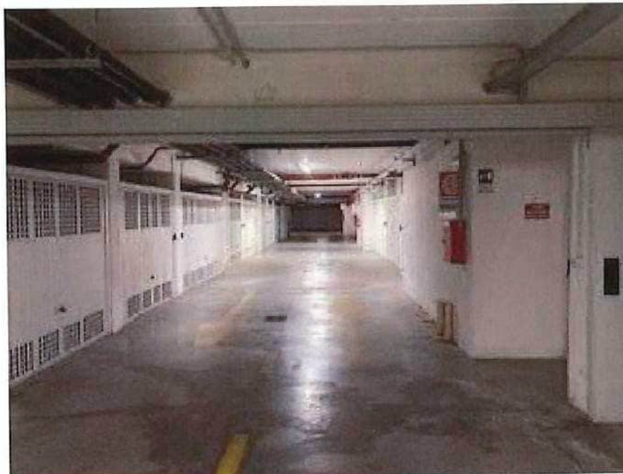
Vista 15 - Particolare rampa di accesso al garage.
