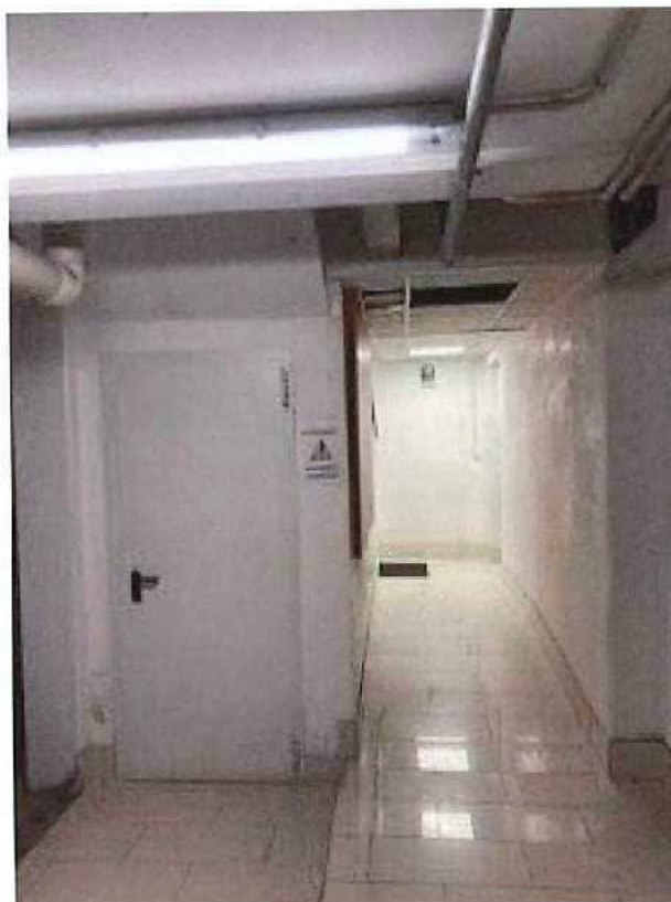
Vista 13 - Corridoio di arrivo alle unità pertinenziali.
