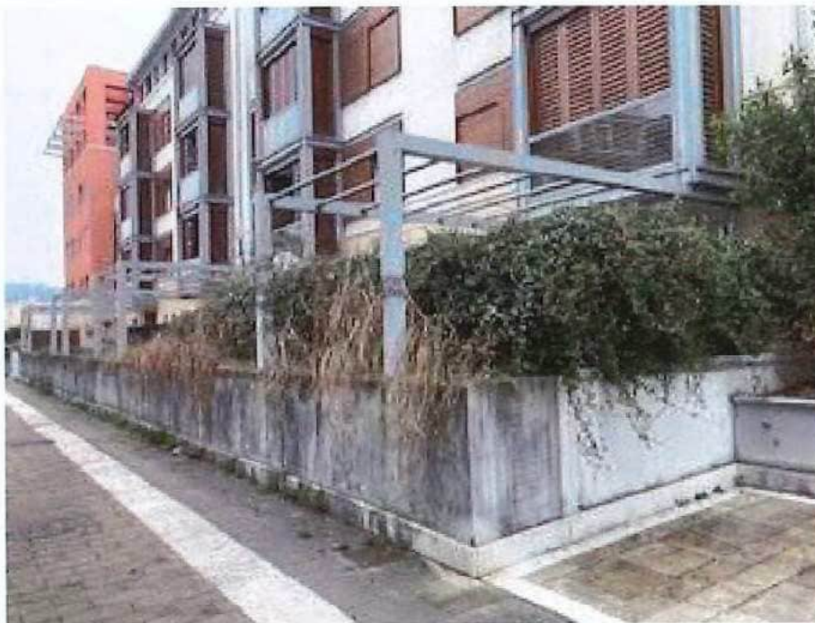
Vista 4 - Particolare dello scoperto esclusivo – porzione ovest.
