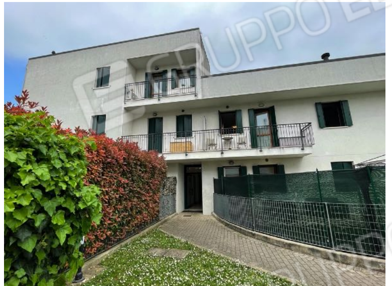
Prospetto Sud dell'edificio (ingresso comune)
