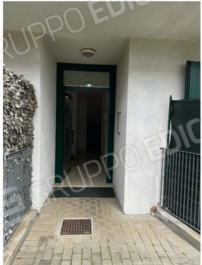
Ingresso comune (piano terra)
