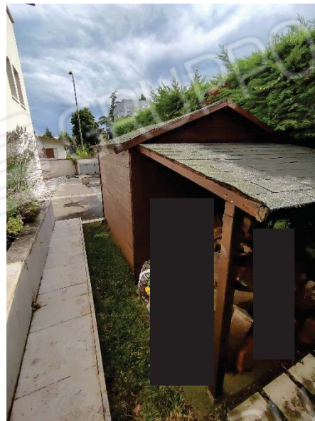
7 Casetta in legno lato Est
