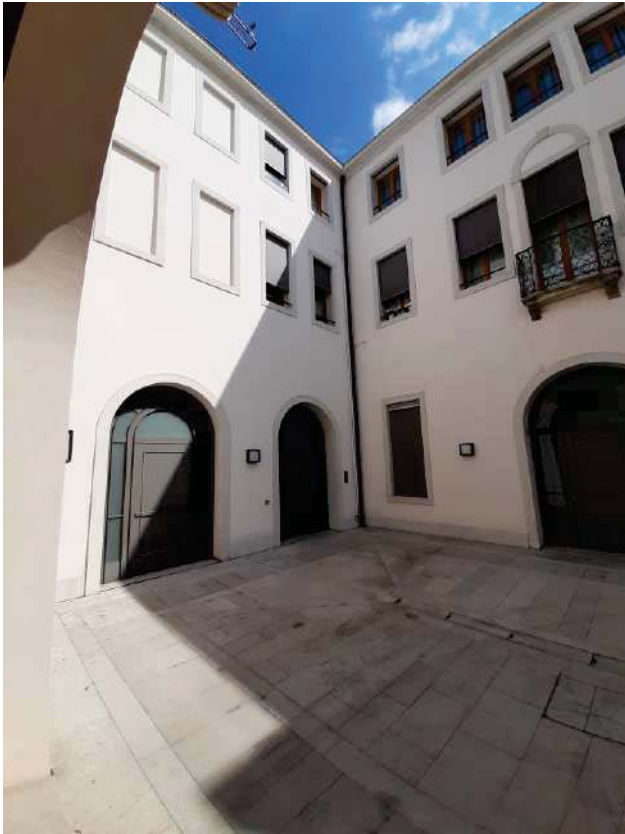
Corte interna comune e androne di ingresso da via XX Settembre
