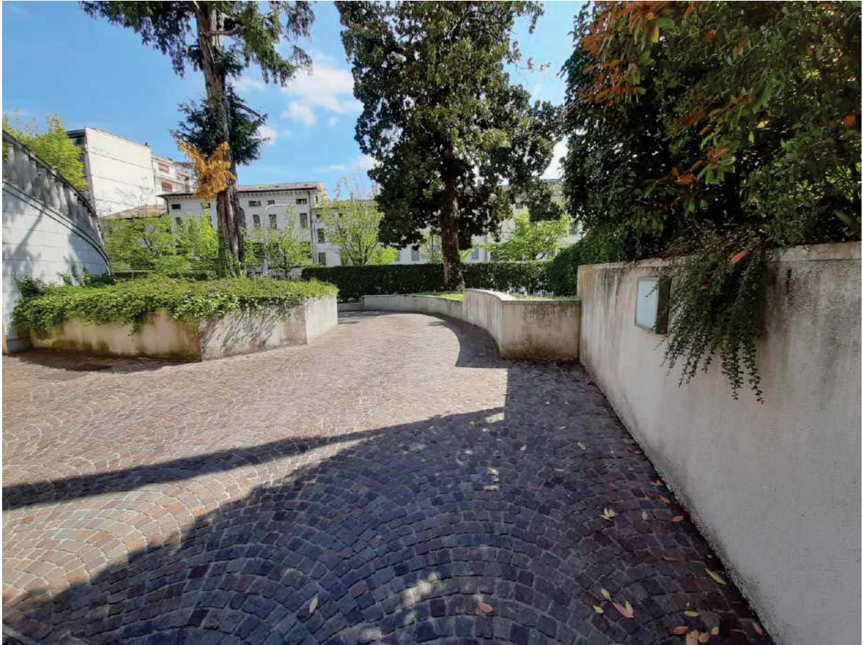
Spazi comuni condominiali piano interrato
