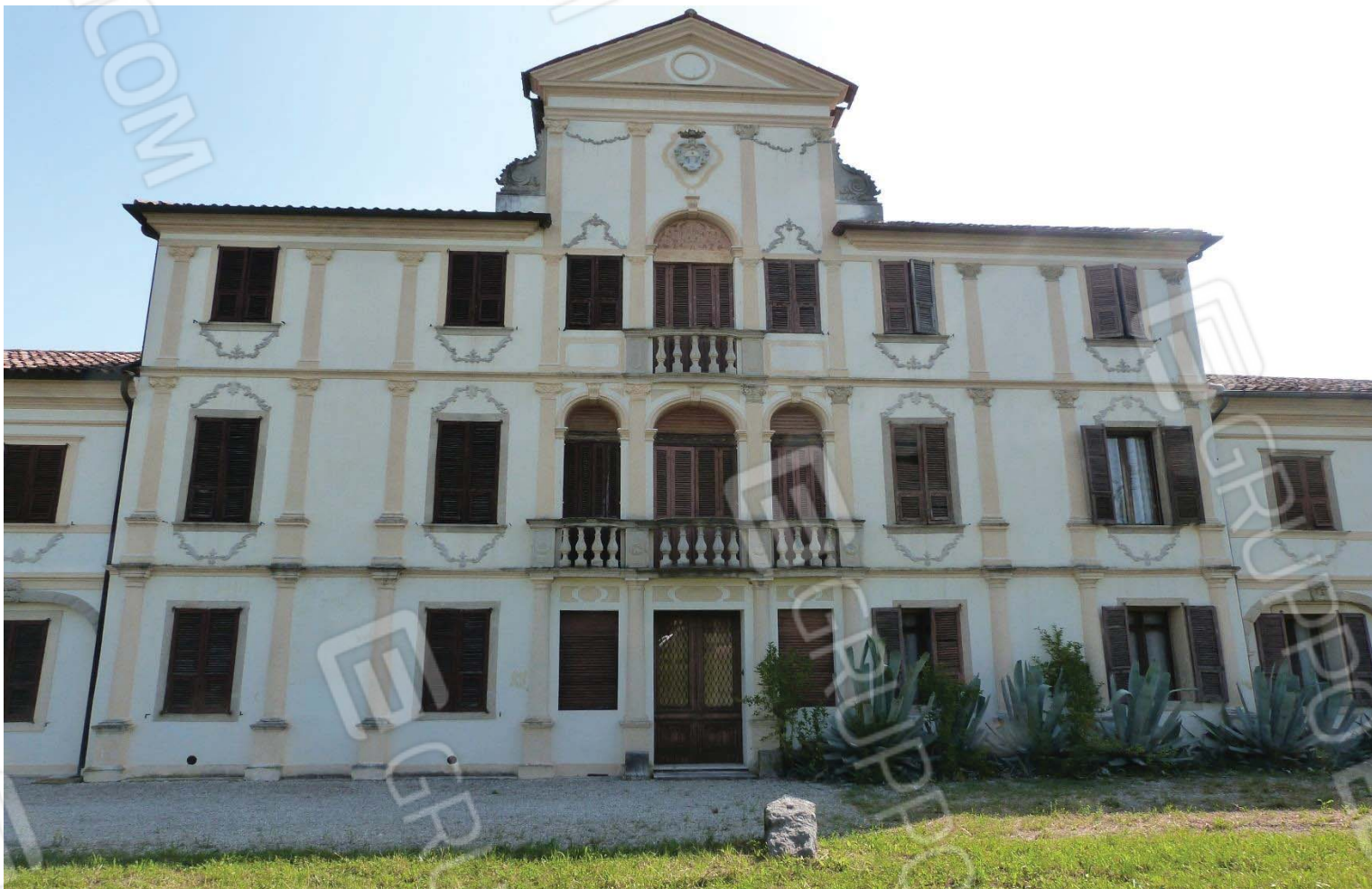
Vista del corpo centrale – prospetto principale.
