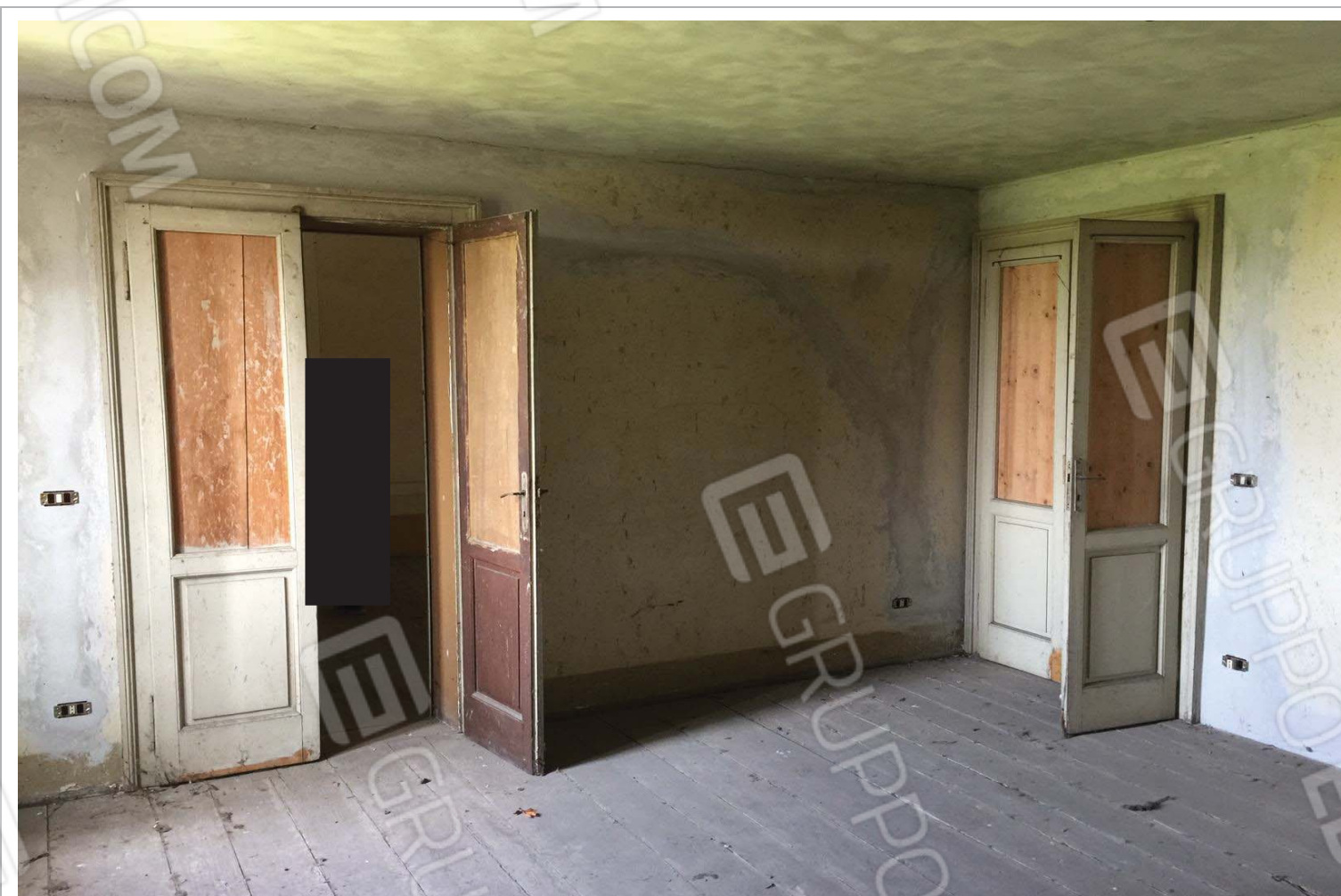
Stanza al piano secondo del corpo centrale quale bene appartenente al LOTTO 1.
