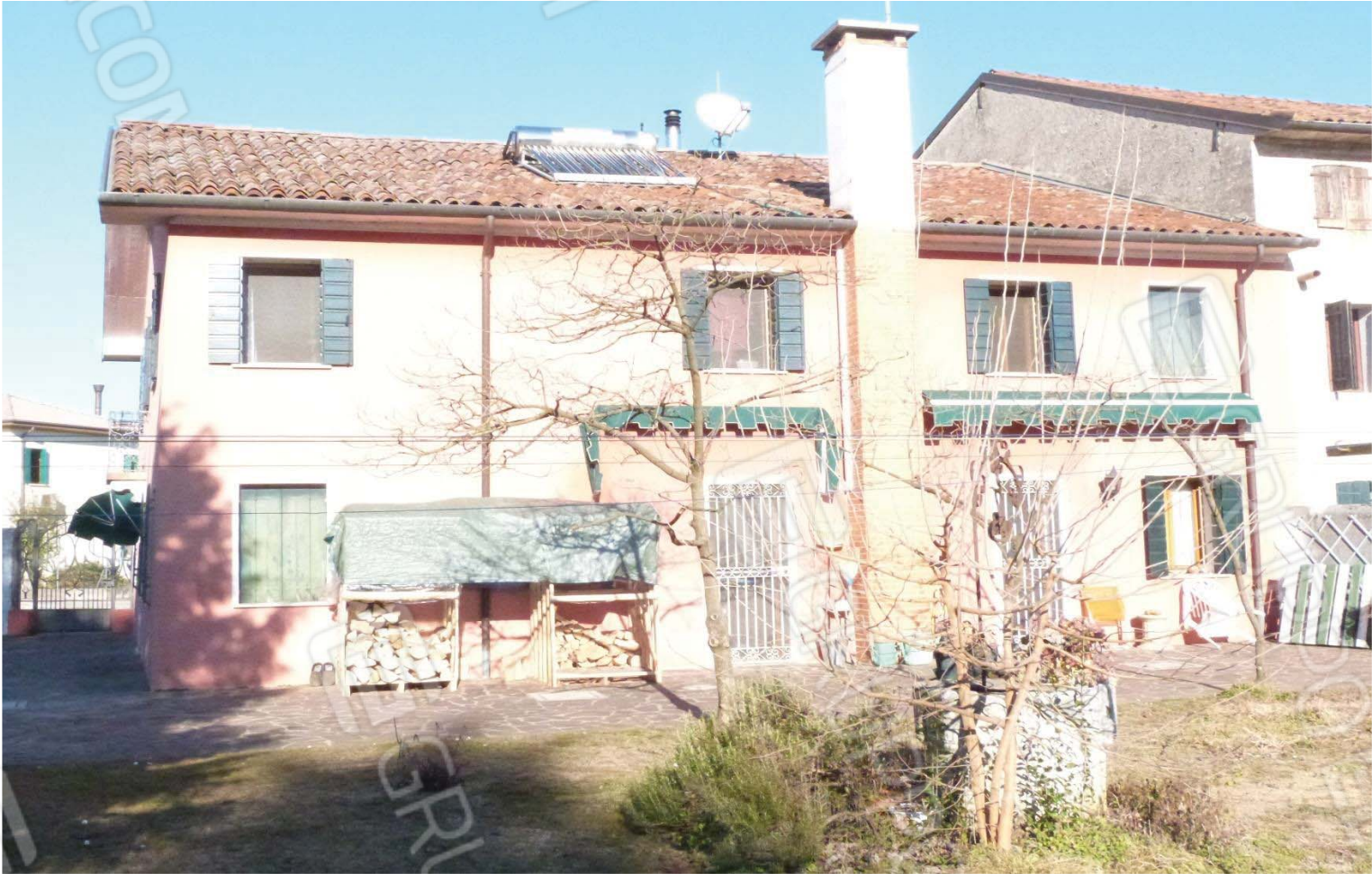
Vista del fronte sud.
