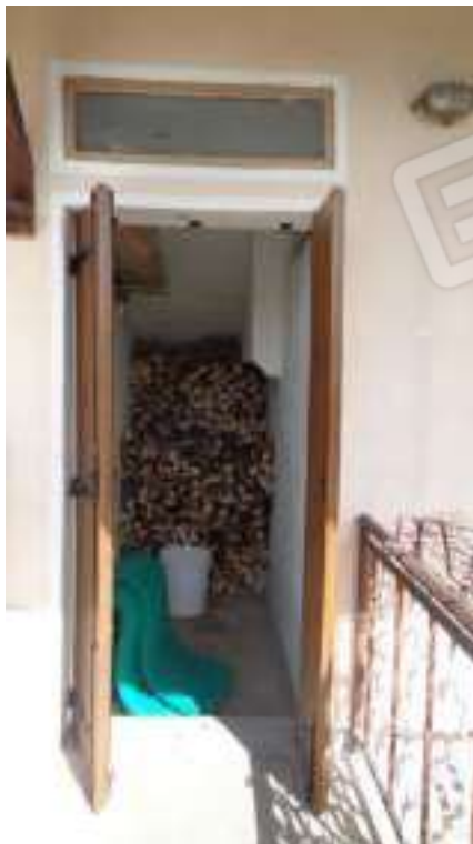
Fotografia C.8 - Vista ingresso ripostiglio (abuso)
