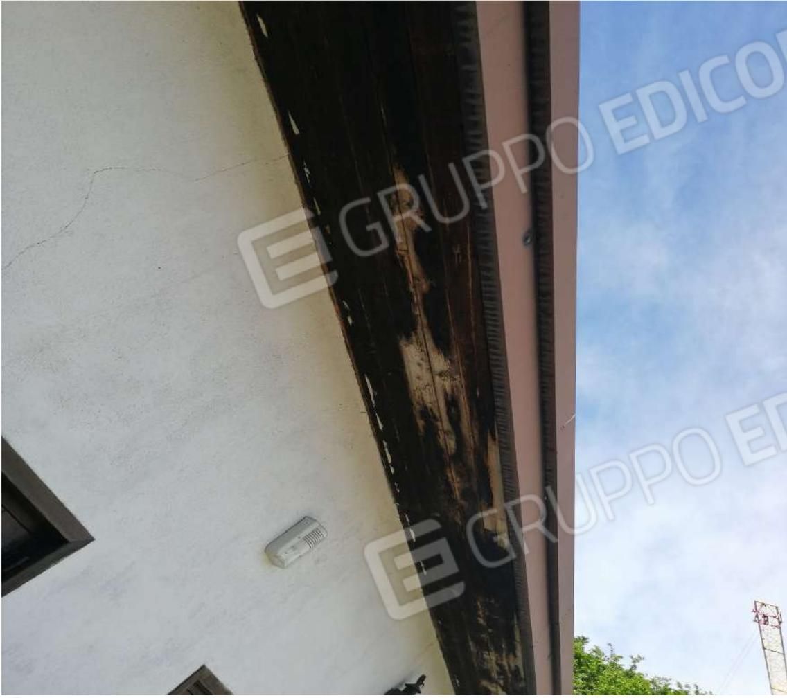
**Fotografia n. 07** – Magazzino: difetti del sottotetto
