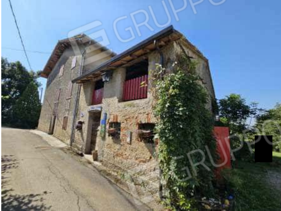
FOTO 1 : vista esterna lato nord-ovest
