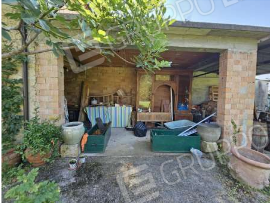
FOTO 3: vista esterna lato ovest
