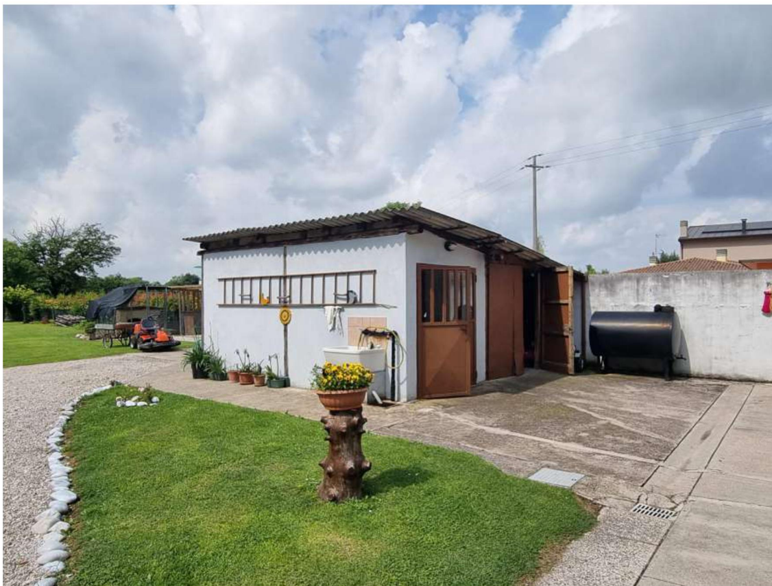
Foto n. 5 – Manufatto non autorizzato
