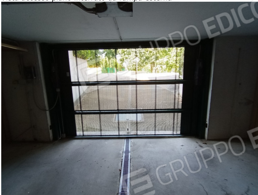
Vista accesso piano interrato da rampa esterna
