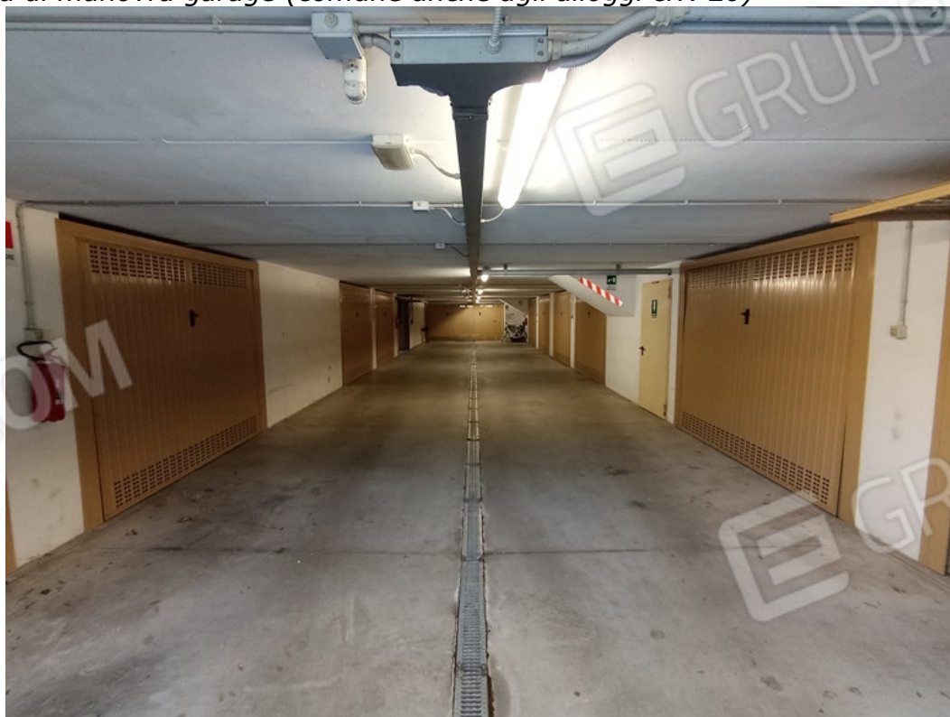
Area di manovra garage (comune anche agli alloggi civ. 20)
