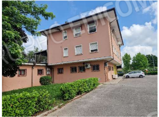
foto n. 2 – fronte sud del condominio
