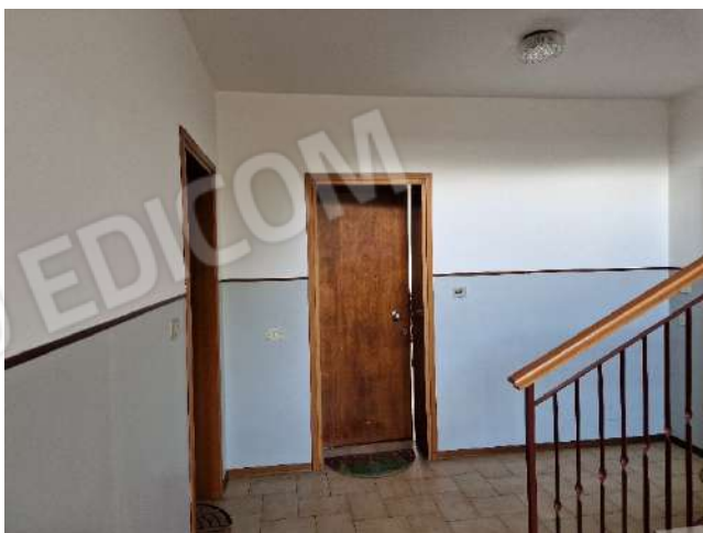
foto n. 5 – portoncino di ingresso appartamento
