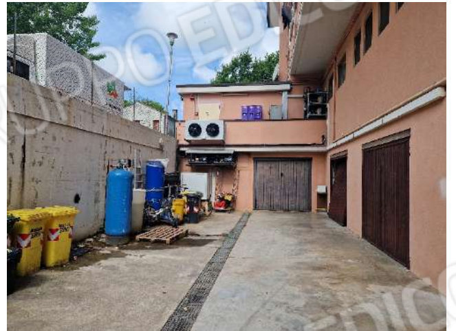
foto n. 14 – rampa di accesso ai garages
