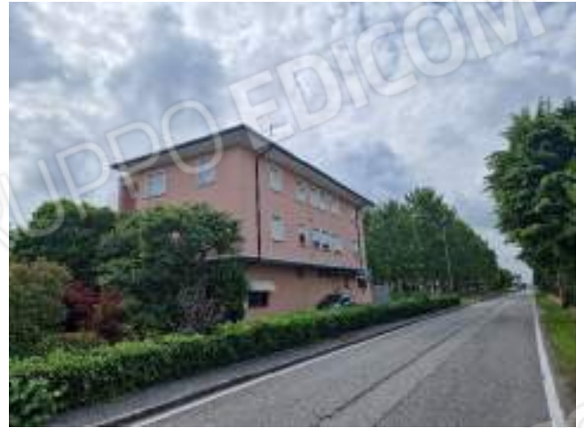
foto n. 2 – fronte ovest del condominio
