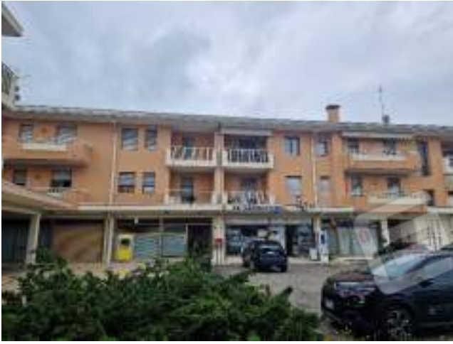
foto n. 1 – fronte ovest del condominio
