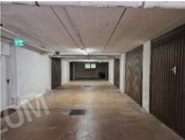
foto n. 15 - corsia di manovra
