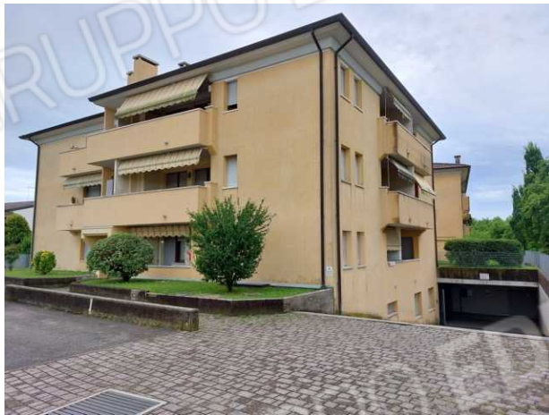
Ingresso autorimessa lato est
