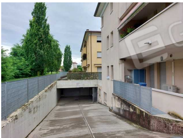
Ingresso autorimessa lato ovest
