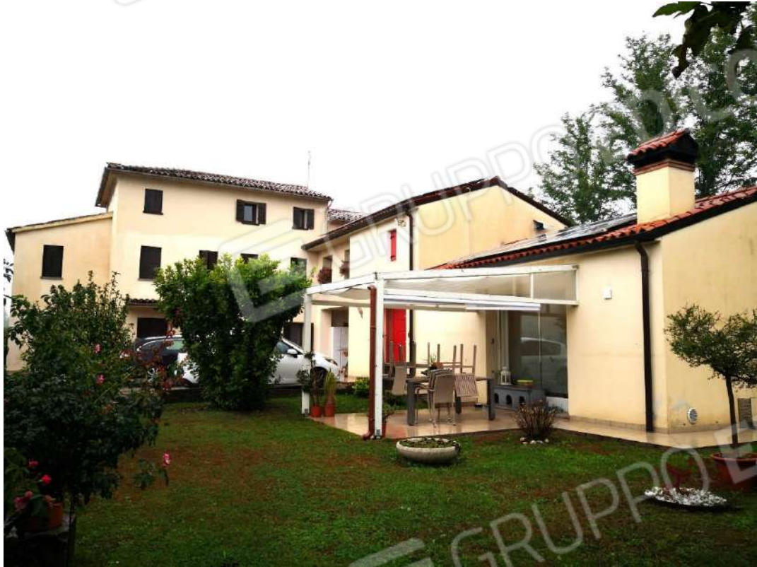
Foto 10: gazebo pompeiana realizzata su fondo di terzi
