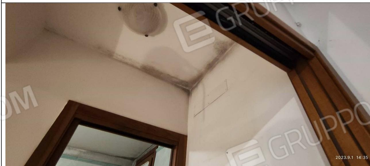
FOTO 19\_PIANO SECONDO/ VANO SCALA/ PARTICOLARE INFILTRAZIONE E/O CONDENZA SU SOFFITTO
