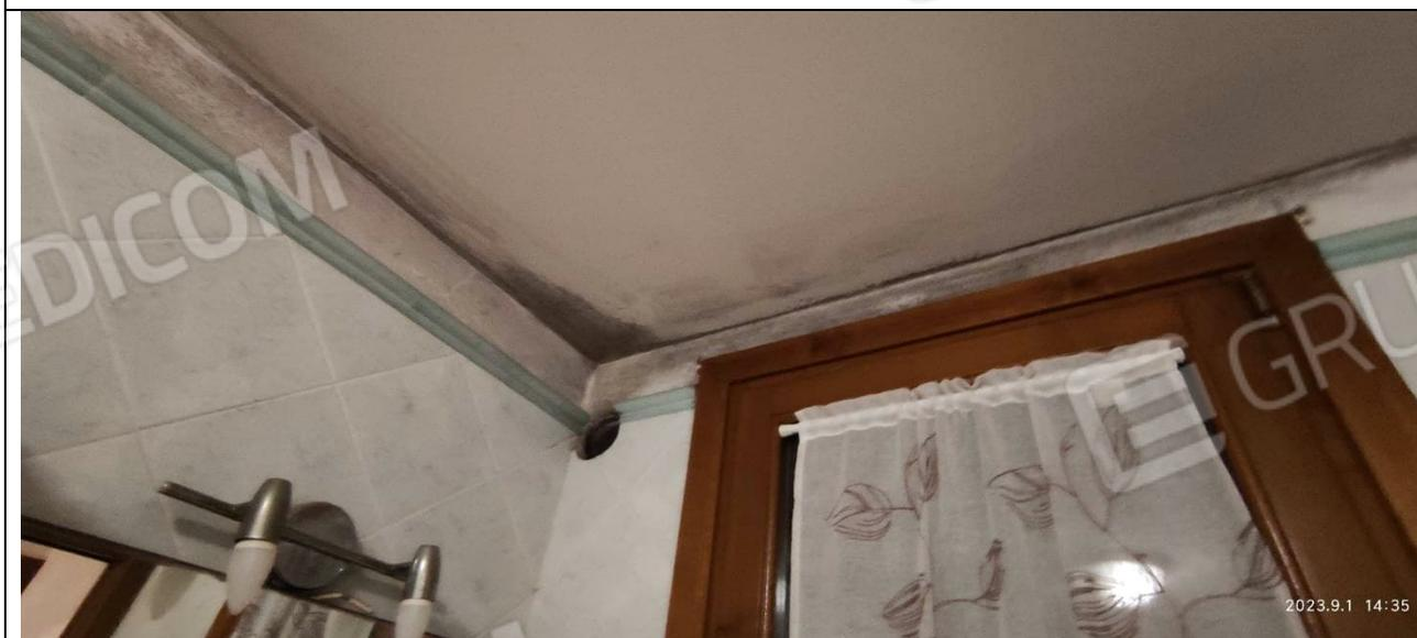
FOTO 20\_PIANO SECONDO/ BAGNO/ PARTICOLARE INFILTRAZIONE E/O CONDENZA SU SOFFITTO
