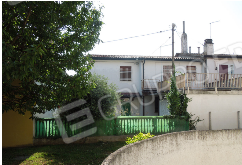
Il prospetto ovest dell'appartamento dalla proprietà contermina
