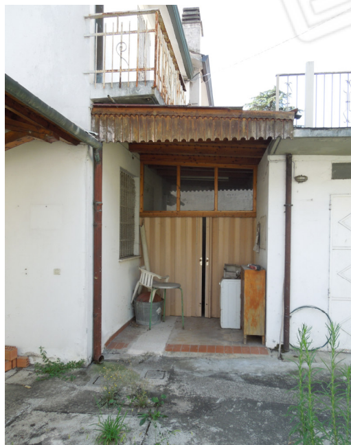
Il portico e la lavanderia tra l'appartamento (a sinistra) e il garage di altra proprietà (a destra)
