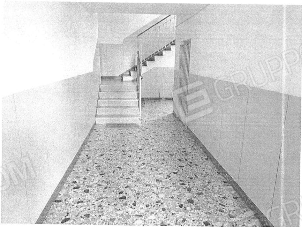
Foto 2 Scorcio dell'ingresso condominiale.
