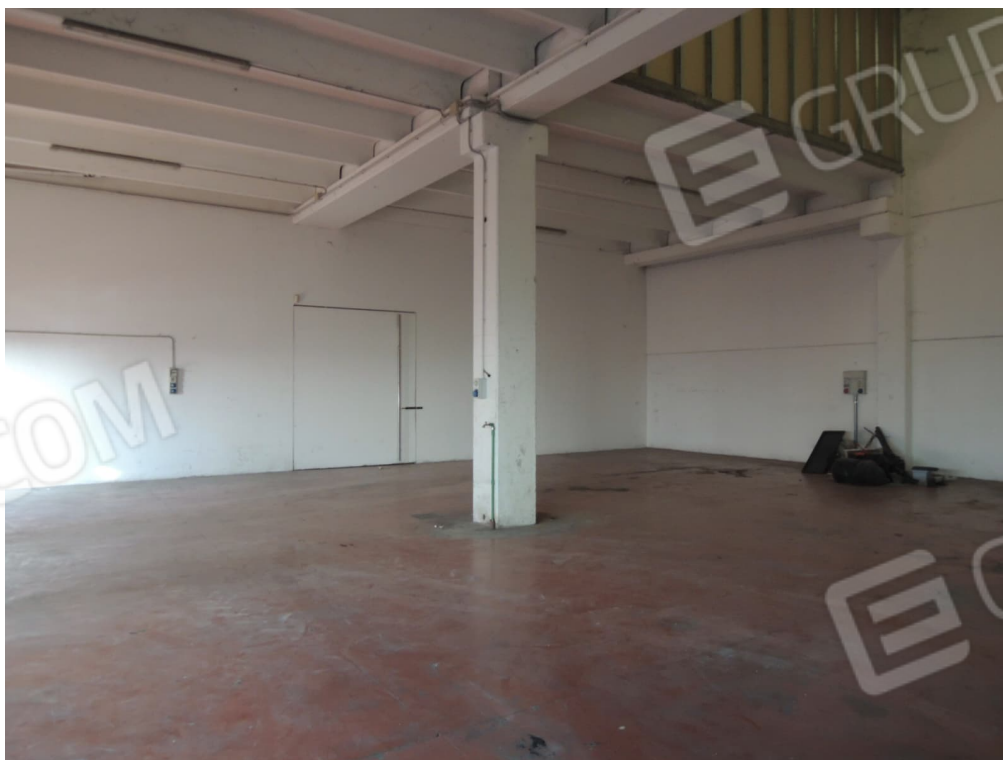
Foto 4 – magazzino piano terra (corpo A)
