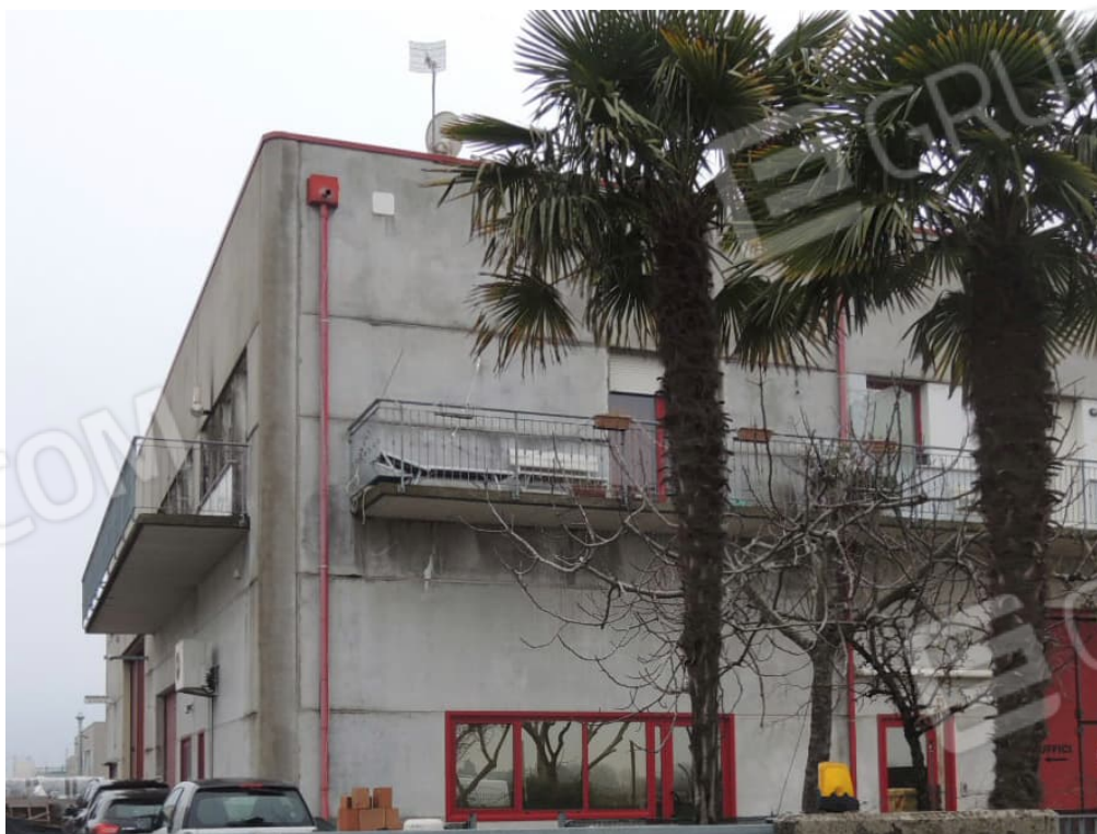
Foto 18 - veduta esterna dell'edificio nella zona d'angolo ove ubicato l'appartamento al piano primo (corpo B)
