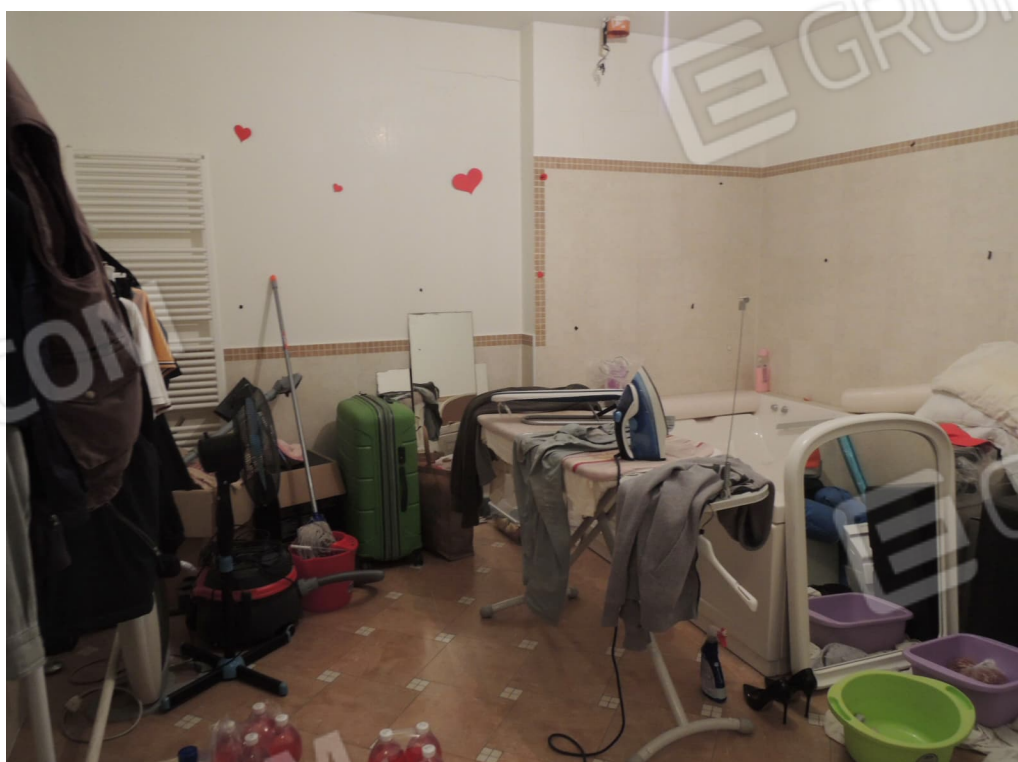
Foto 24 – bagno (corpo B)
