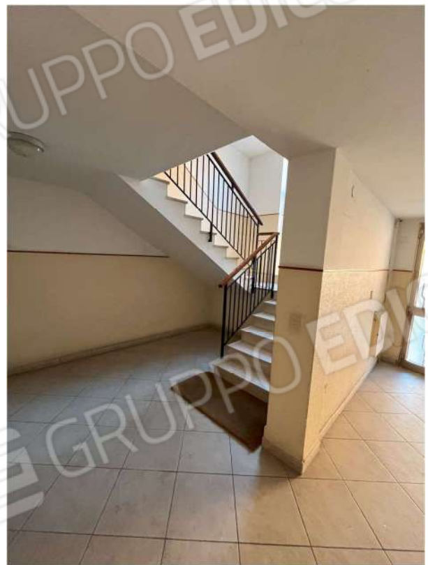
Particolari dell'ingresso condominiale
