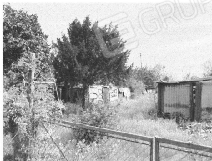
Foto 5: Baracche da demolire
