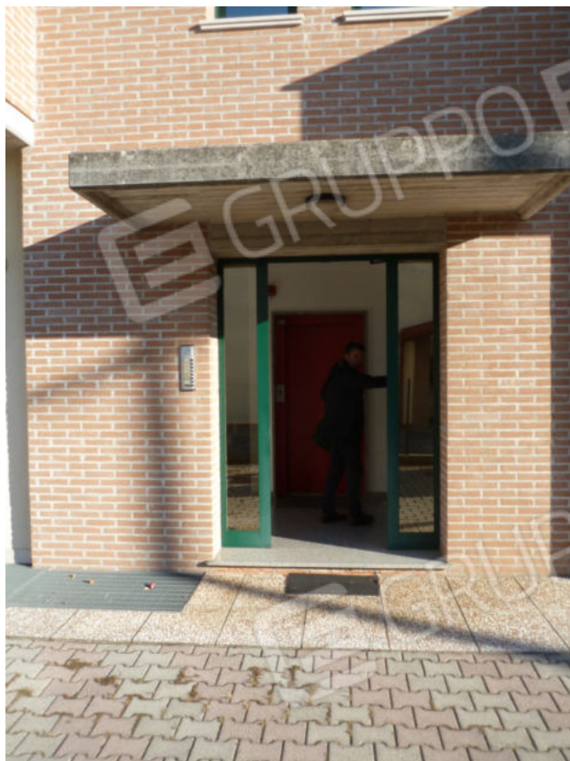
5. Ingresso condominiale al piano terra su prospetto sud
