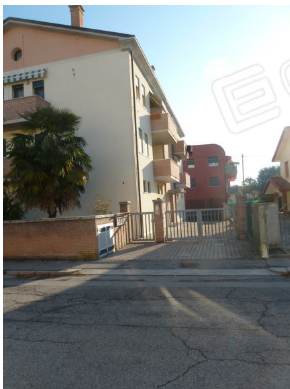
2. Accessi carraio e pedonale al condominio
