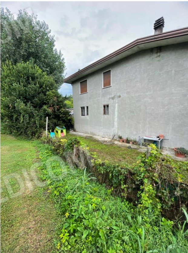
VEDUTA PARTE P.LLA 1031 OCCUPATA DA TERZI
