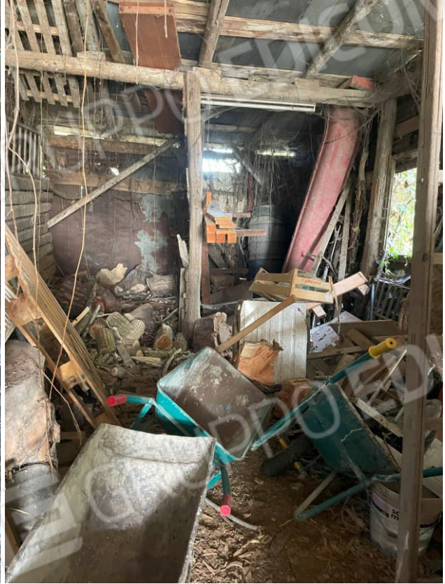
VEDUTA MAGAZZINO MAPPALE 1032
