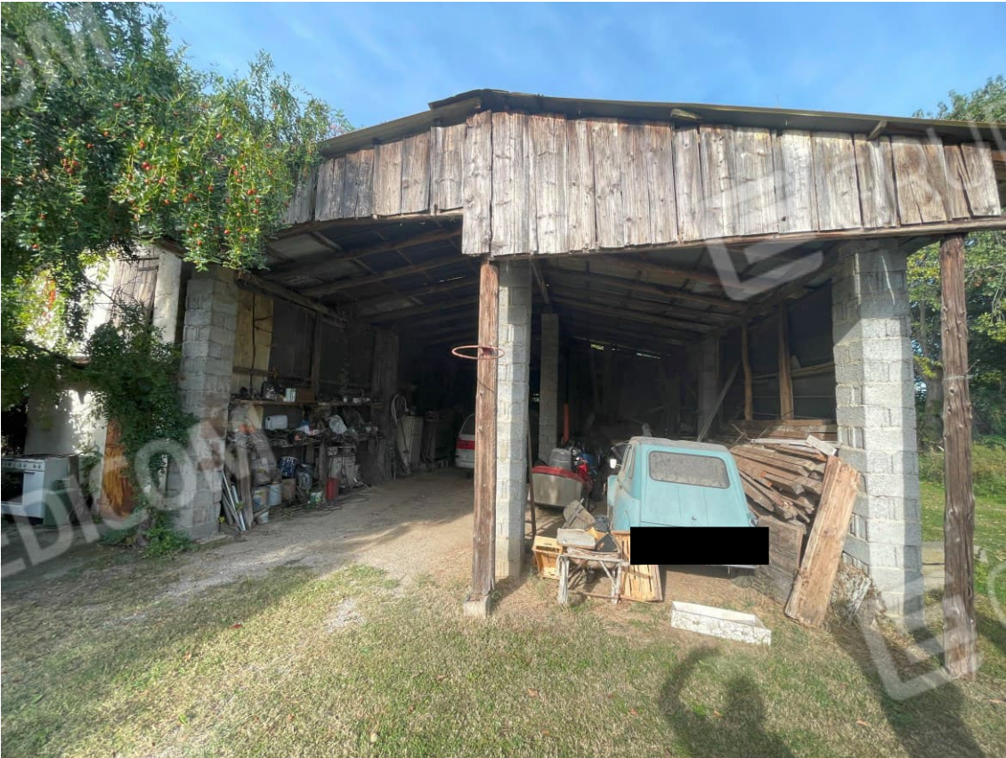
VEDUTA MAGAZZINO MAPPALE 1032
