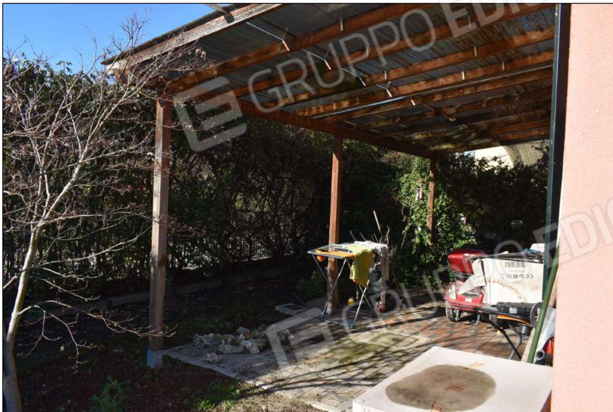
foto 12 - area esterna con porticato
