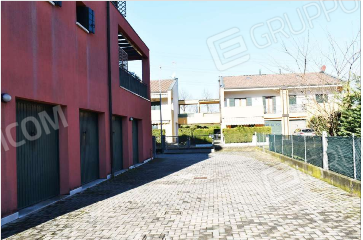
foto 03 - area scoperta condominiale
