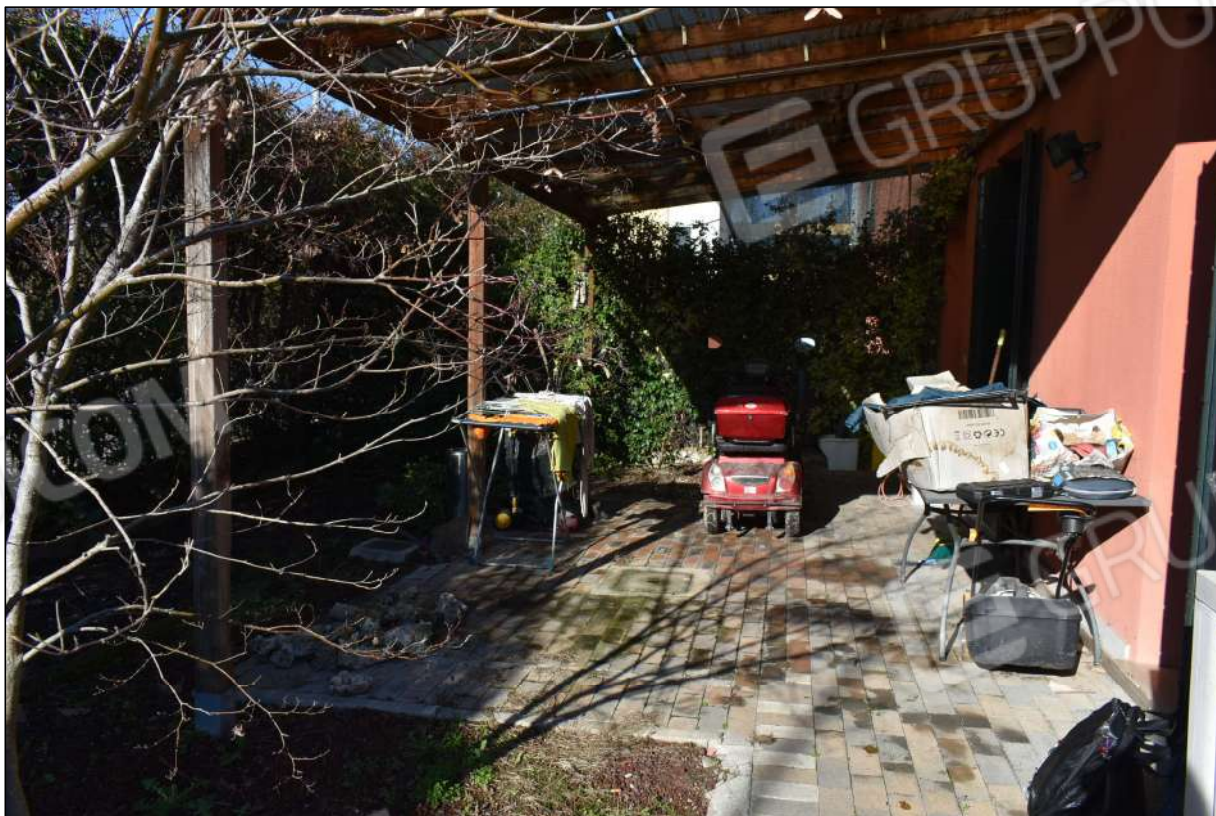
foto 13 - area esterna con porticato
