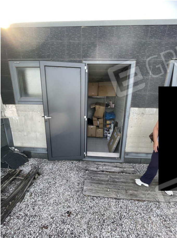
Veduta locale tecnico con accesso dalla copertura
