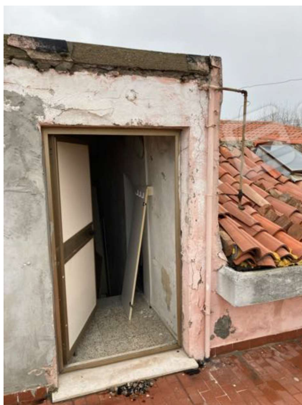
FOTO 13 - L'accesso alla terrazza.
