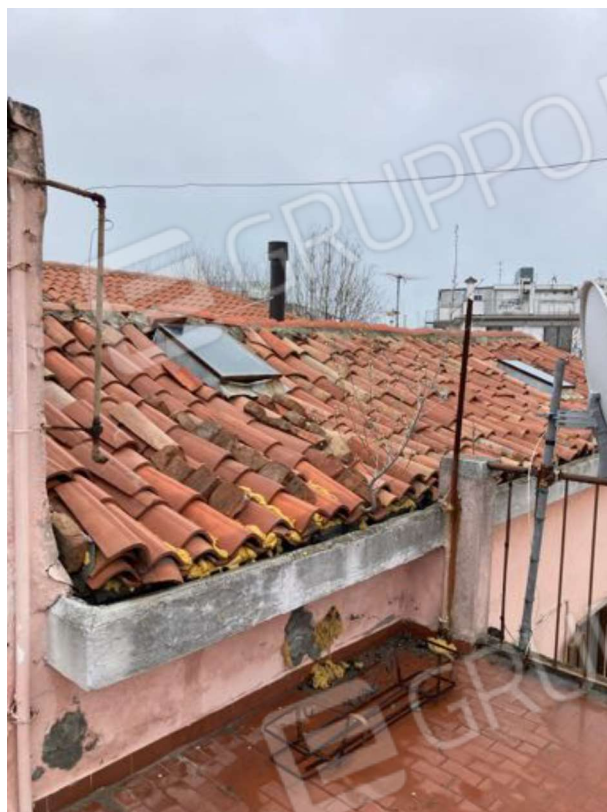
FOTO 12 - La copertura e la terrazza.
