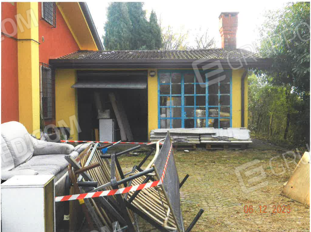
LOTTO 3 - Autorimessa - vista esterna
