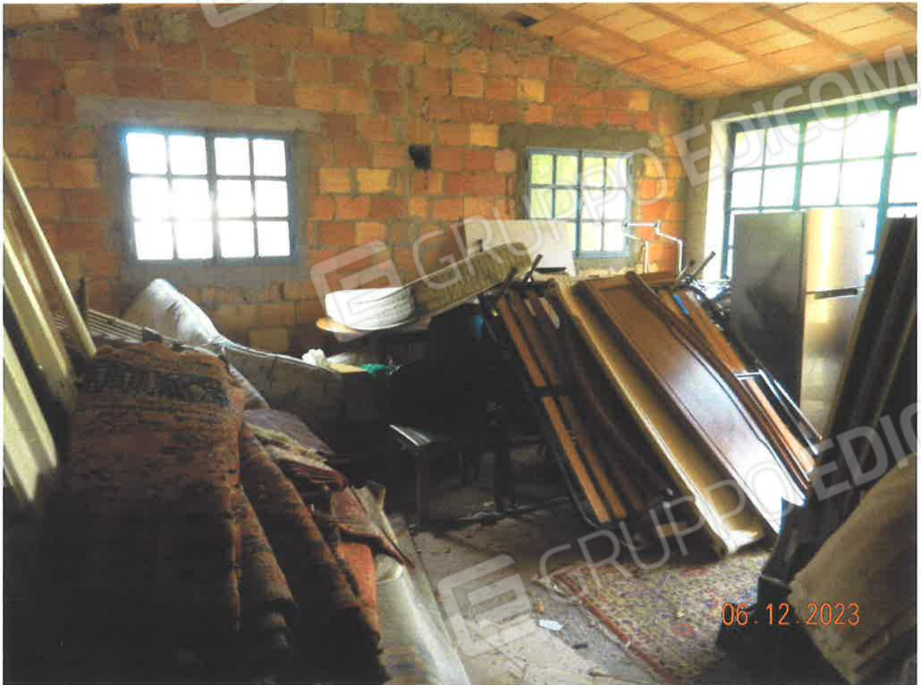
LOTTO 3 - Autorimessa - vista interna
