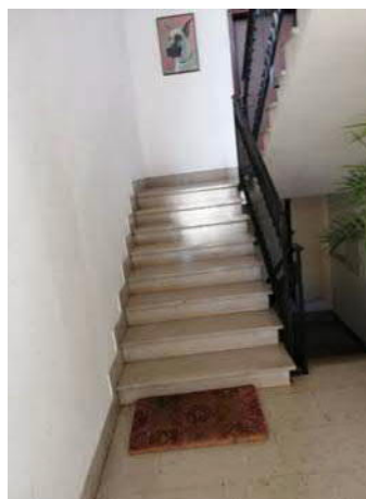
Foto 3: Atrio e scala condominiale
