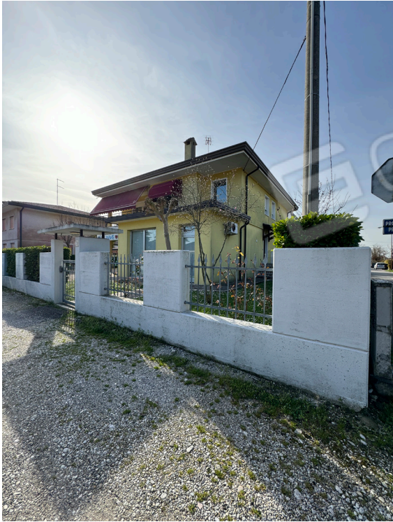
1. Vista esterna fabbricato
