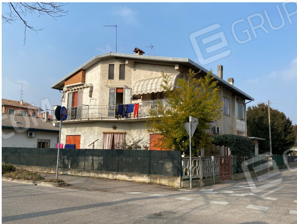
Foto n. 2: vista del fabbricato da nord-ovest
