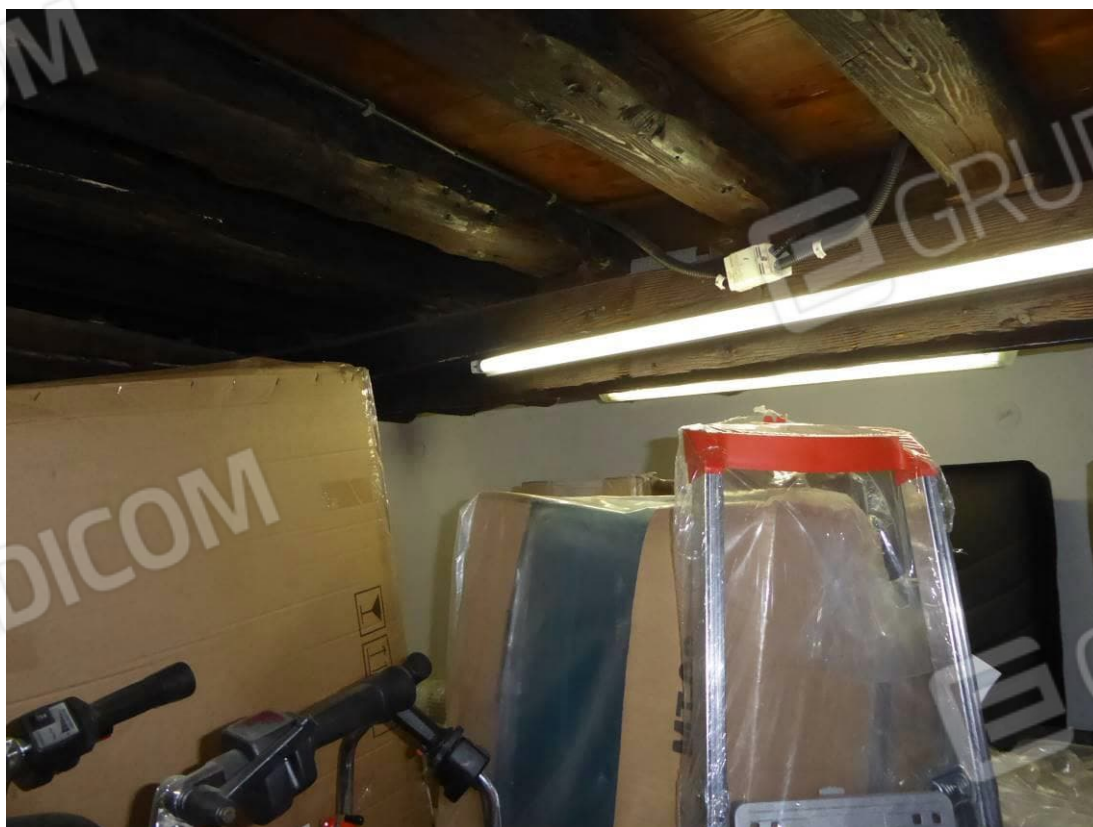
Foto 12 – Part. 30 sub. 2 magazzino
