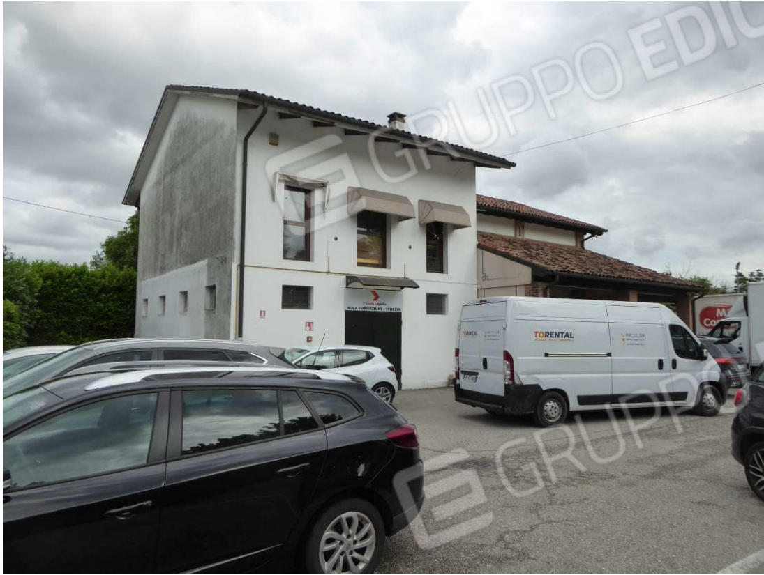
Foto 41 – Part. 125 vista da ovest
