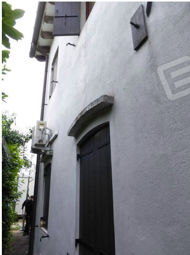
Foto 67 – Part. 125 sub 2 prospetto est
