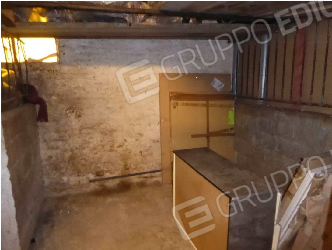
Foto 26 – Part. 30 sub. 3 interno scuderia
