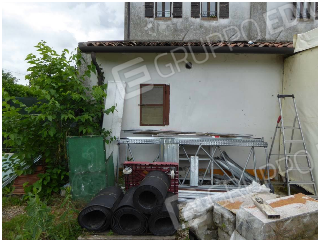
Foto 36 – Part. 30 sub. 3 prospetto nord
