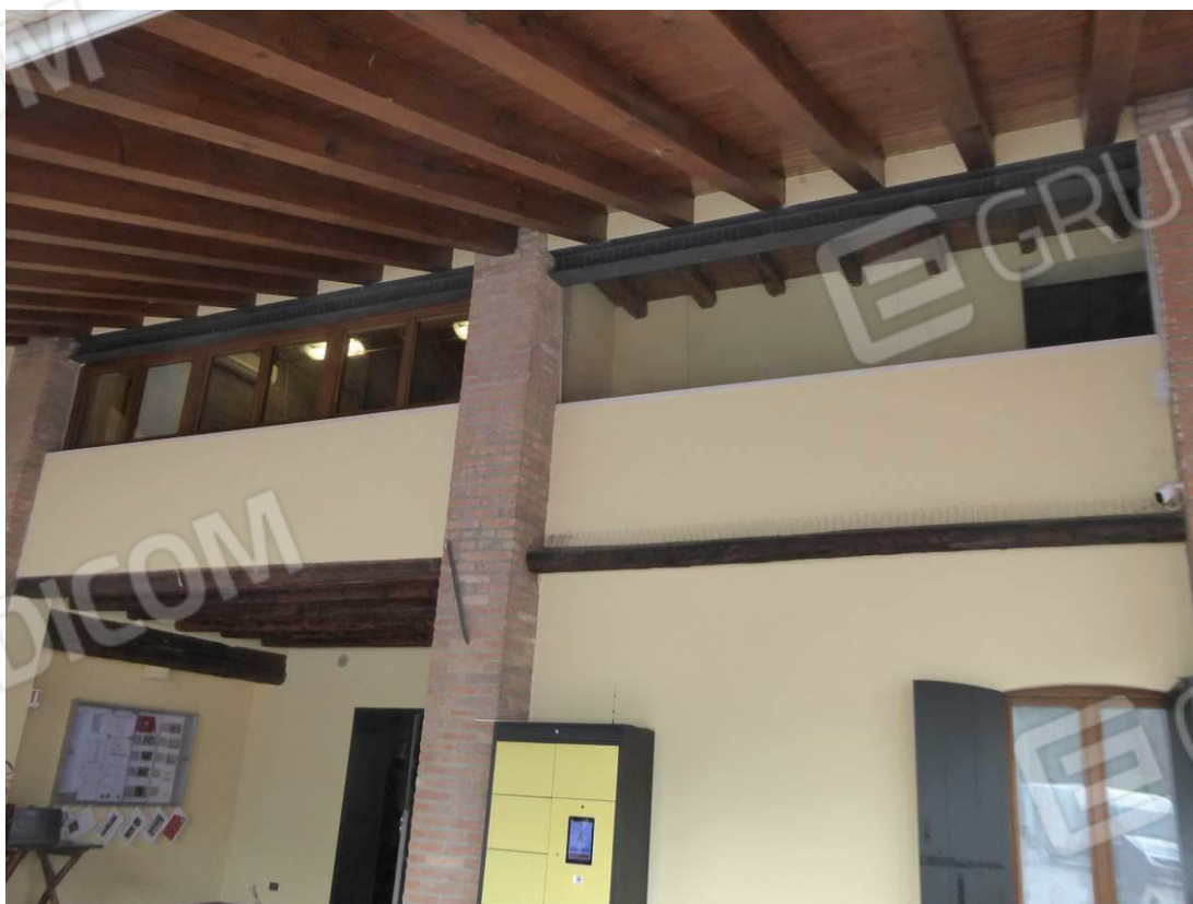
Foto 81 – Part. 125 sub 2 portico
