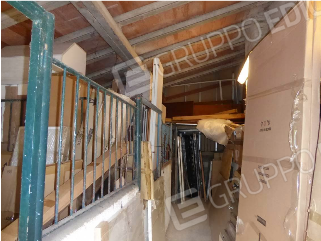
Foto 28 – Part. 30 sub. 3 interno scuderia
