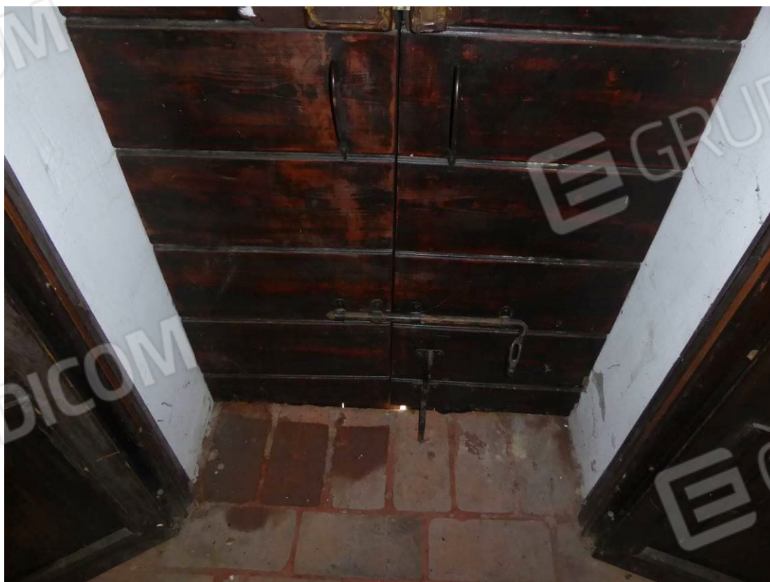
Foto 10 – Part. 30 sub. 2 magazzino
