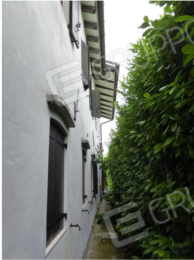
Foto 66 – Part. 125 sub 2 prospetto est
