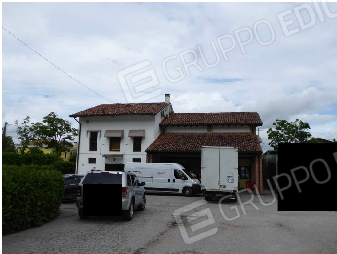
Foto 82 – Part. 125 sub 2 prospetto Ovest
