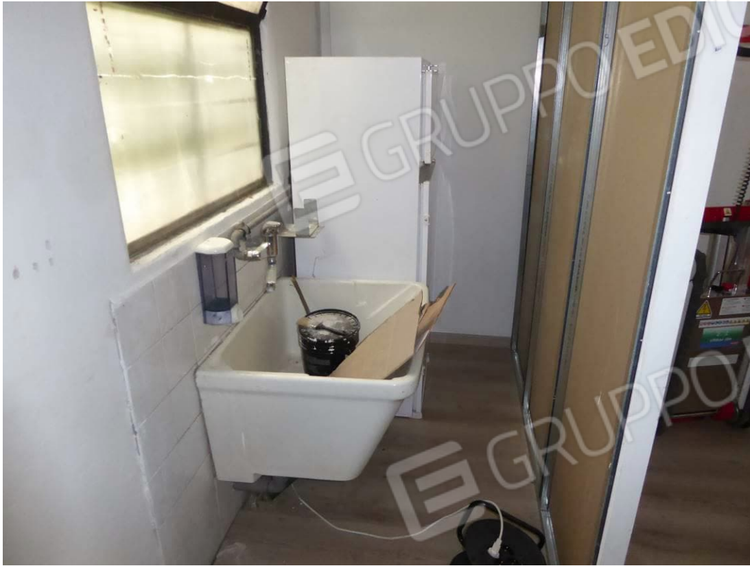
Foto 45 – Part. 125 sub 2 deposito attrezzature nord
