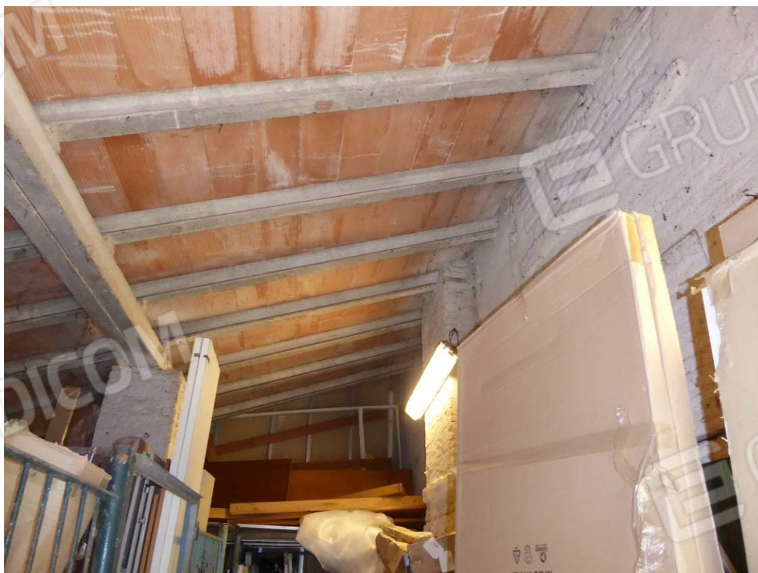
Foto 25 – Part. 30 sub. 3 interno scuderia
