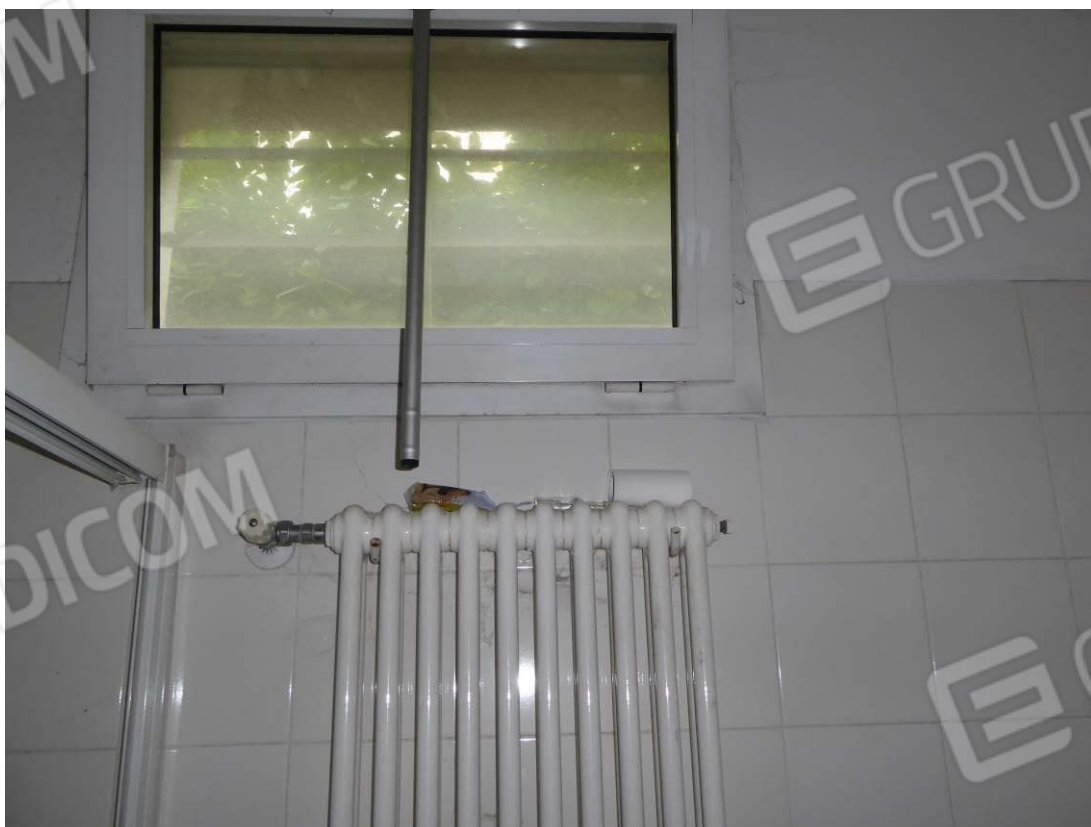
Foto 55 – Part. 125 sub 2 servizio igienico piano terra
