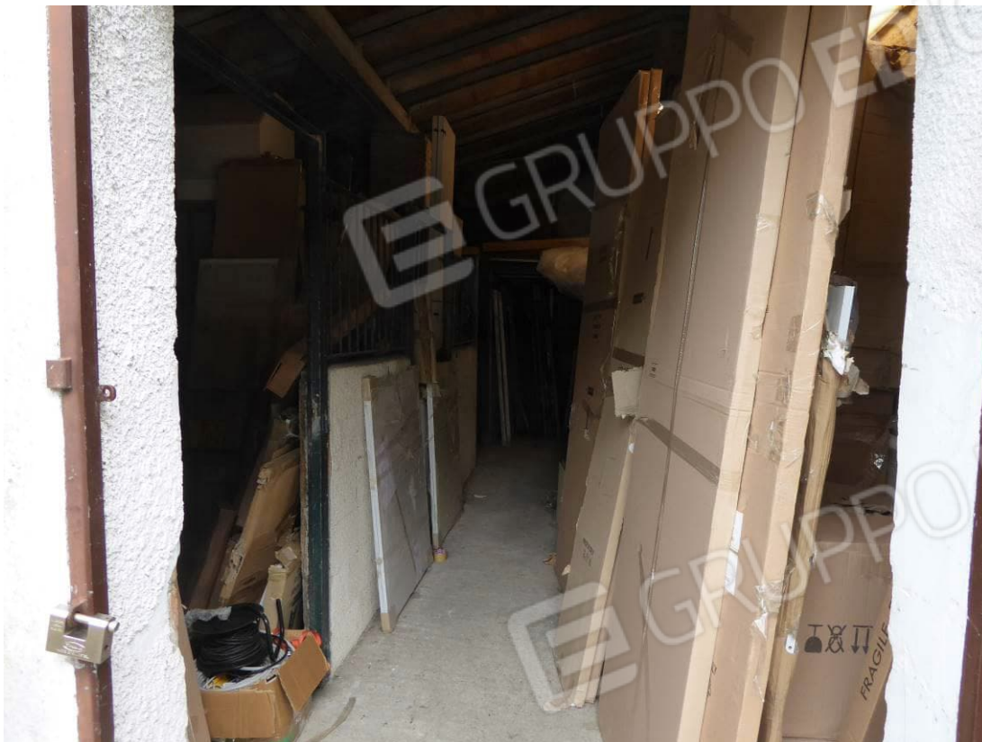
Foto 20 – Part. 30 sub. 3 ingresso scuderia
