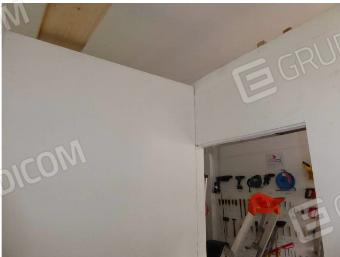
Foto 48 – Part. 125 sub 2 deposito attrezzature nord
