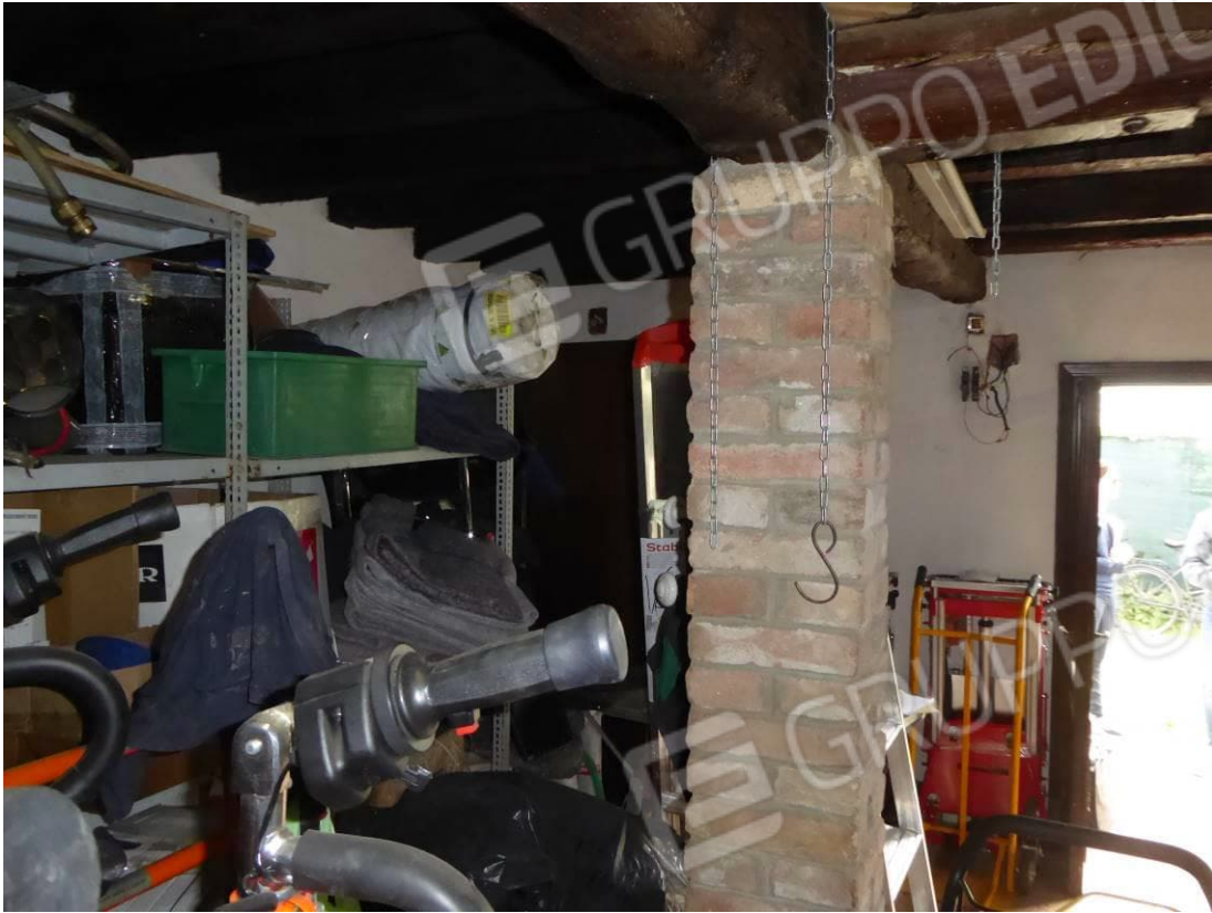
Foto 15 – Part. 30 sub. 2 magazzino
