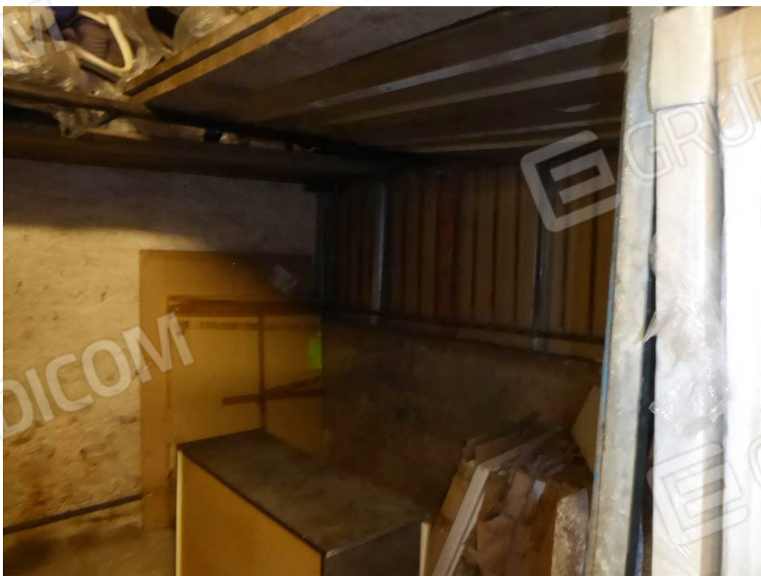
Foto 27 – Part. 30 sub. 3 interno scuderia
