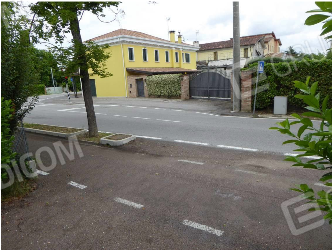
Foto 2 – accesso carrai Via Chiesa di Campocroce
