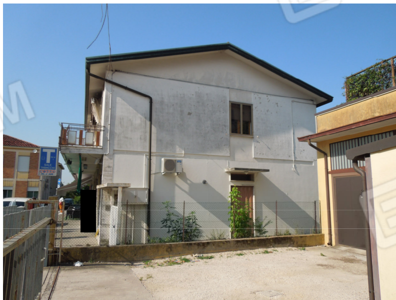
Il prospetto nord da Piazza San Martino col portoncino d'ingresso.
