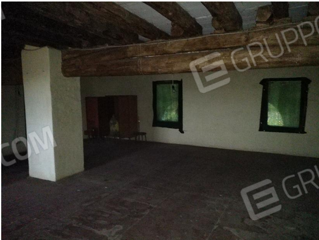
Foto 24 Particolare del magazzino/granaio a P1.
