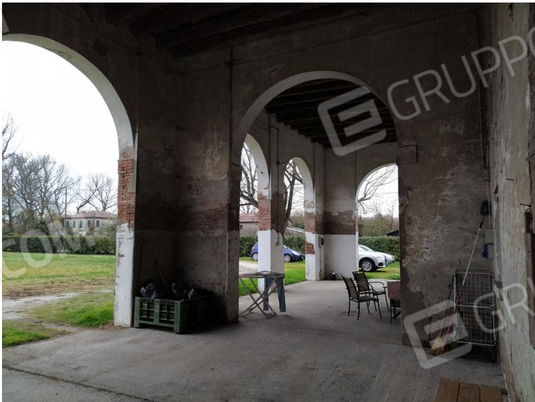
Foto 10 Vista del portico.
