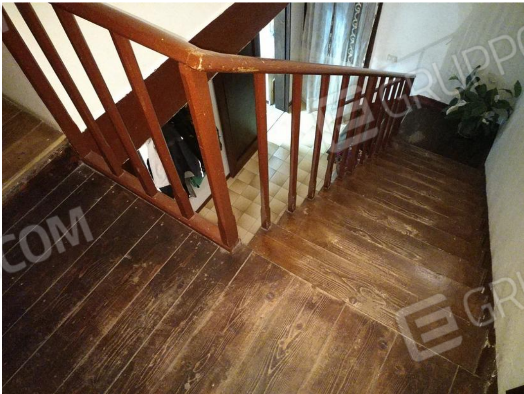
Foto 16 Scorcio della scala di accesso al piano primo.
