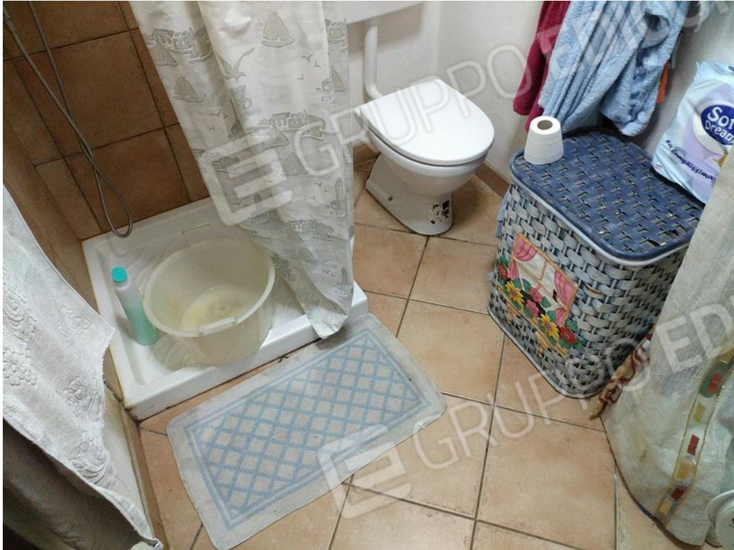
Foto 15 Scorcio del WC ricavato al piano terra.
