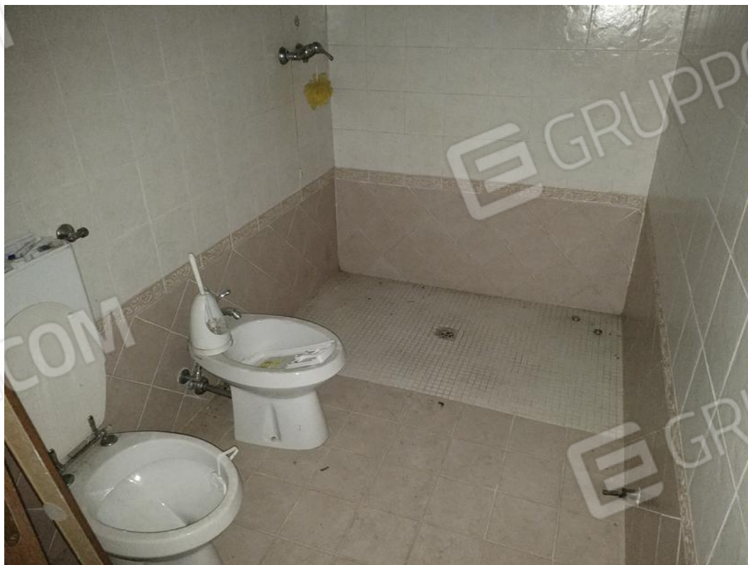
Foto 22 Particolare di un wc ricavato nel magazzino a PT.
