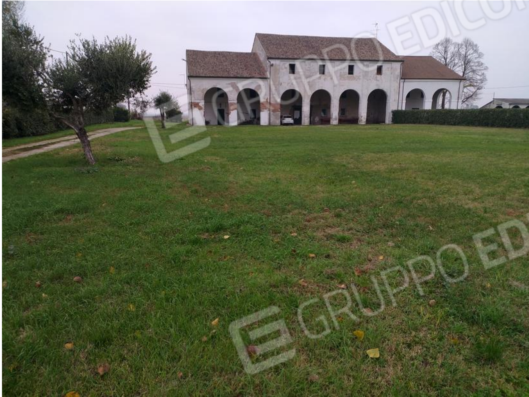
Foto 3 Vista dell'edificio e del terreno di pertinenza.
