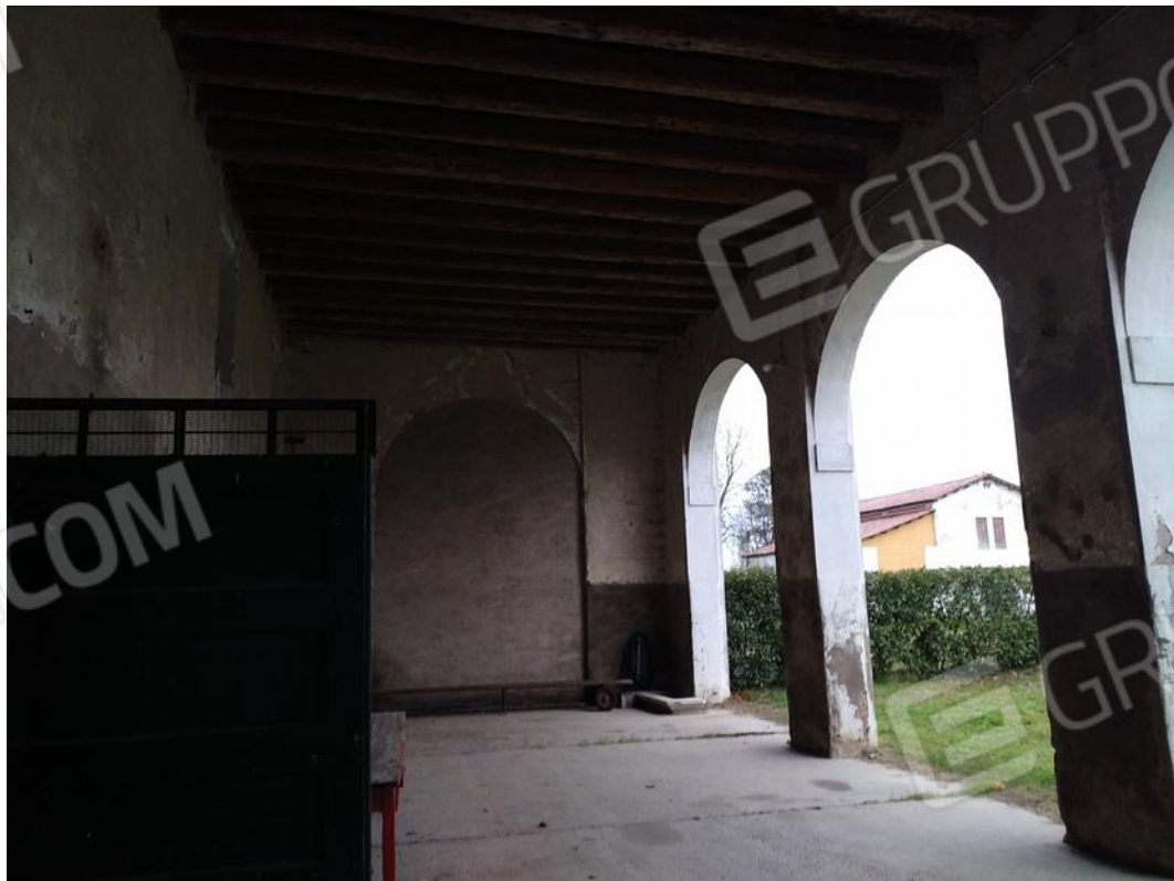
Foto 12 Vista del portico.
