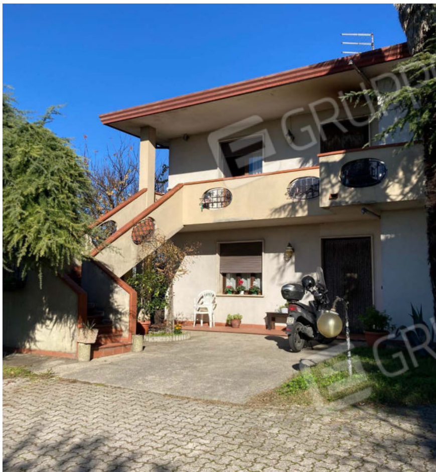
Foto n. 3: Vista scala d'ingresso al piano primo
