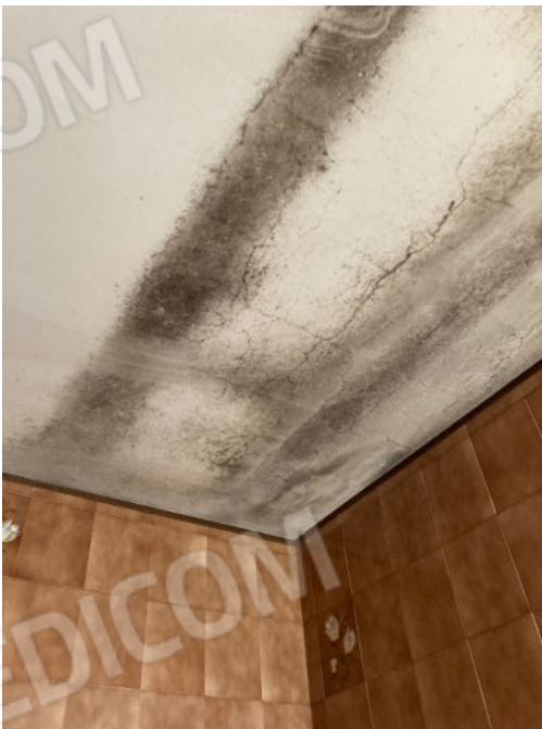
Foto n. 16-17: particolare soffitto del bagno annerito
