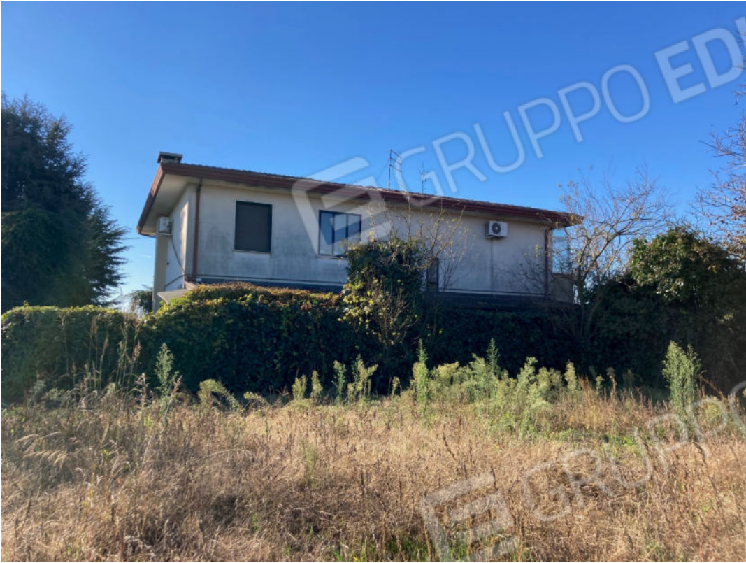
Foto n. 5: Vista del fabbricato da nord
