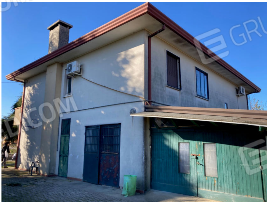
Foto n. 4: Vista del fabbricato nord-est
