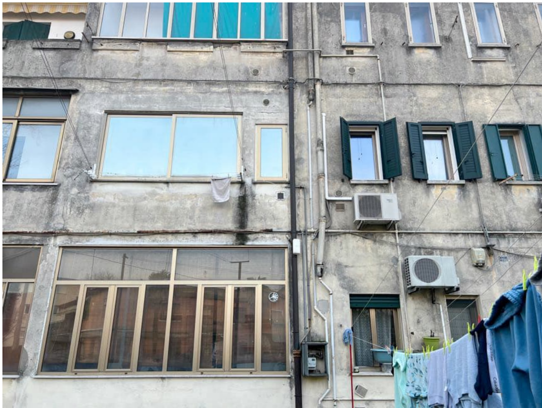
Foto n. 4 Particolare del prospetto sud-est
