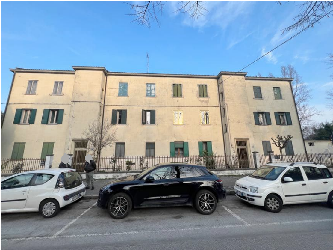
Foto n. 1 Vista del prospetto sud-ovest del fabbricato su Via Beccaria
