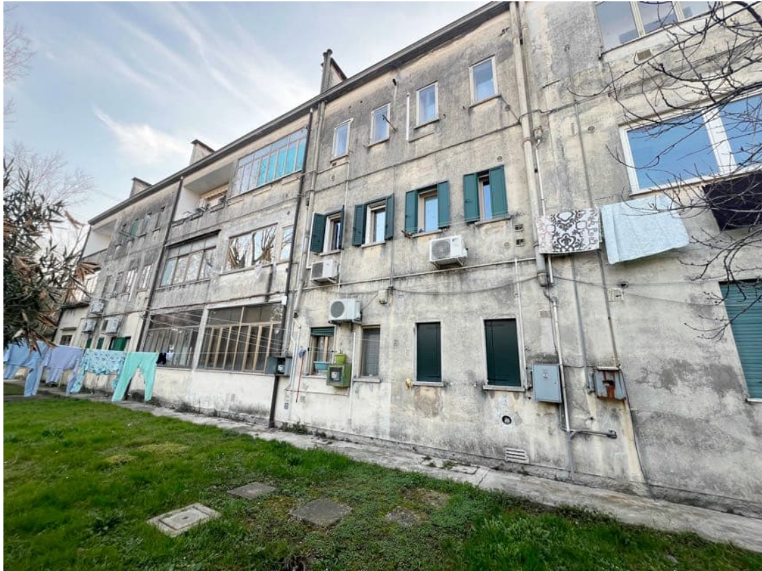
Foto n. 3 Prospetto nord-est del fabbricato
